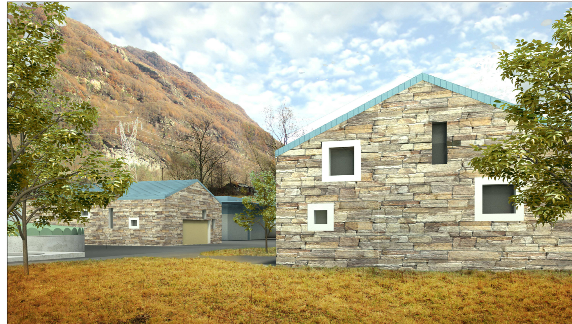
IMPIANTO DI POTABILIZZAZIONE - VISTA VERSO EST, PARTICOLARE VASCHE INSPESIMENTO FANGHI E LOCALI TECNICI PRESSO INGRESSO OVEST
