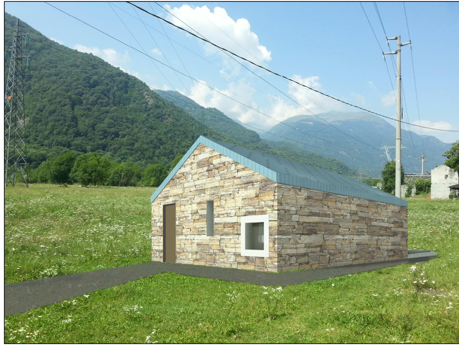
LOCALE TECNICO PUNTO DI PRESA DELL'IMPIANTO DI POTABILIZZAZIONE (LOC. BARDONETTO) - VISTA VERSO OVEST
