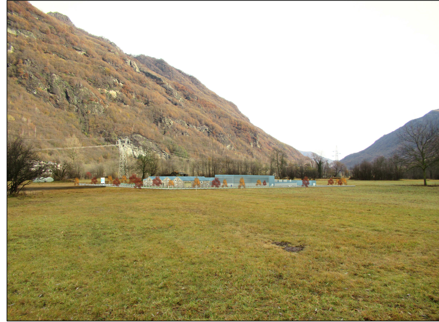
IMPIANTO DI POTABILIZZAZIONE - VISTA DAI TERRENI AGRICOLI AD EST DELL'IMPIANTO DI DEPURAZIONE ESISTENTE PRESSO PRAIE
