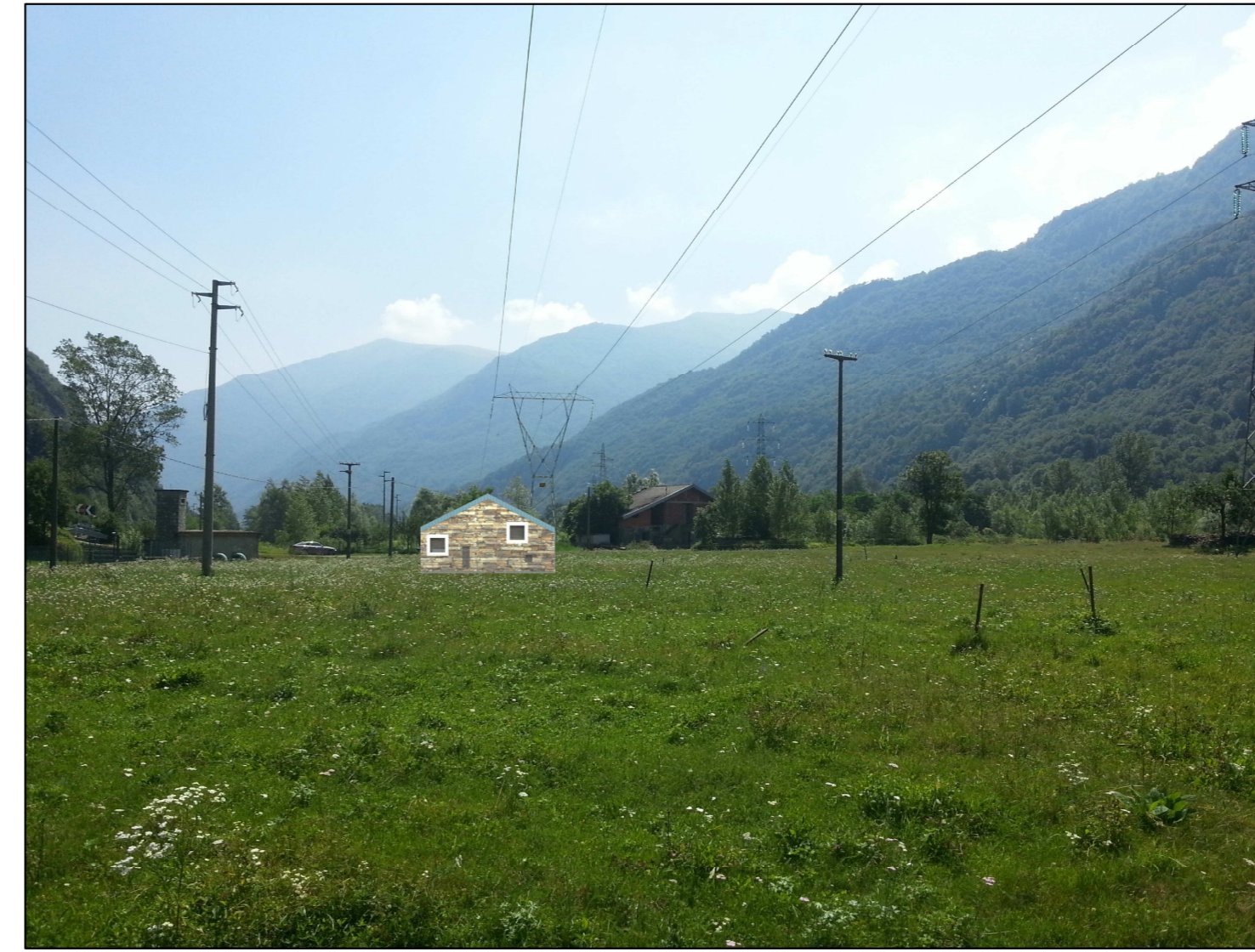
LOCALE TECNICO PUNTO DI PRESA DELL'IMPIANTO DI POTABILIZZAZIONE (LOC. BARDONETTO) - VISTA VERSO EST
