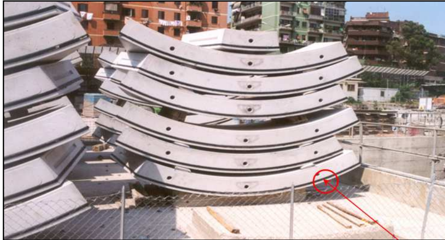
Figura 48– Conci prefabbricati con guarnizioni in neoprene a tenuta idraulica
