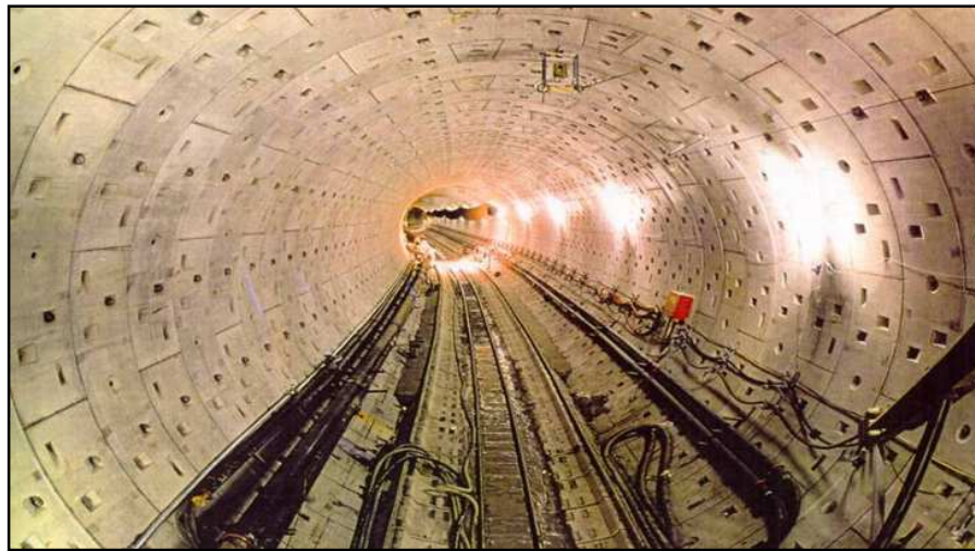
Figura 49– Galleria realizzata con TBM
