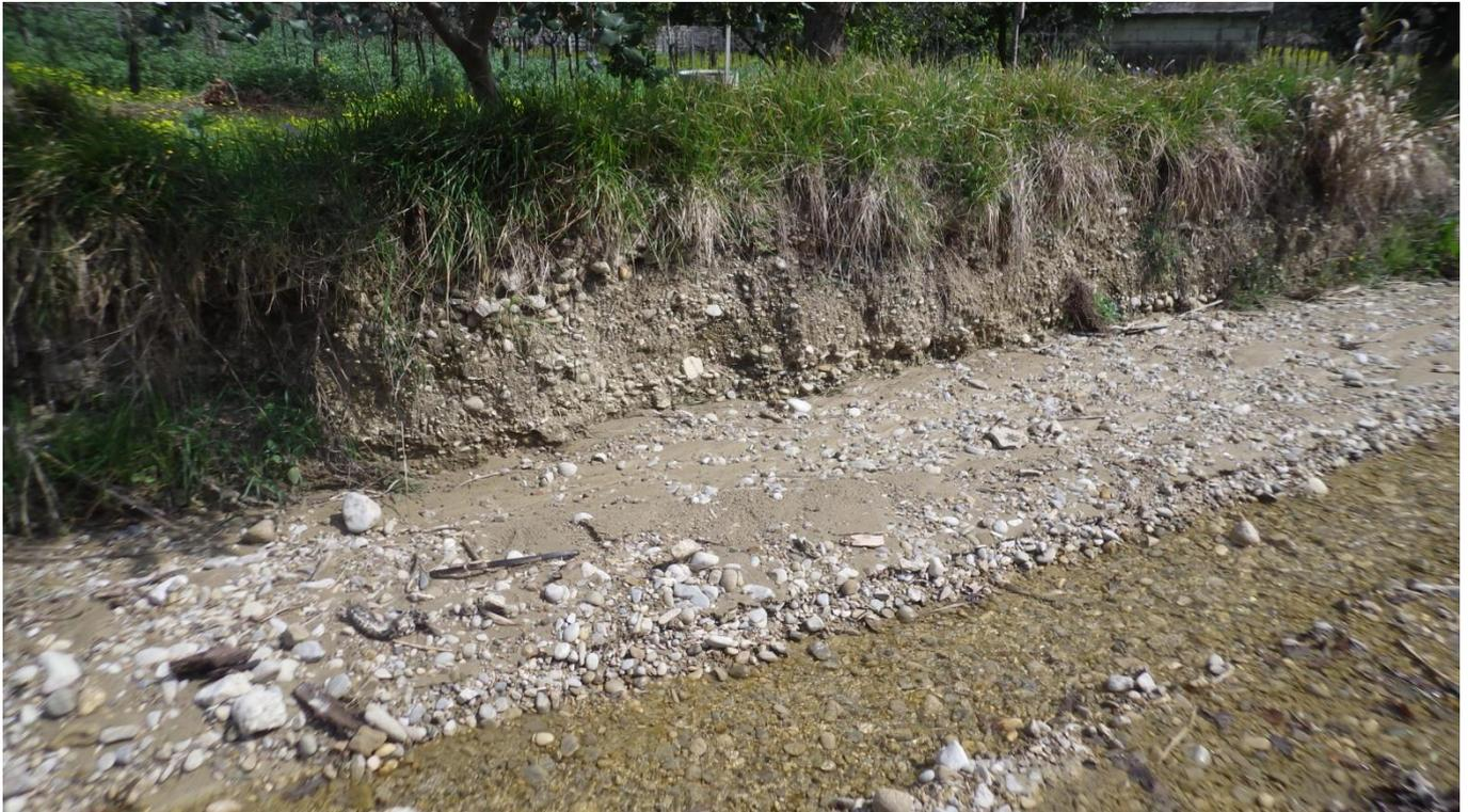
**Foto 15- Scarpatata di erosione fluviale presente lungo l'alveo all'altezza del km 34+200, in corrispondenza di un'area di attenzione potenzialmente elevata (Apa).**
