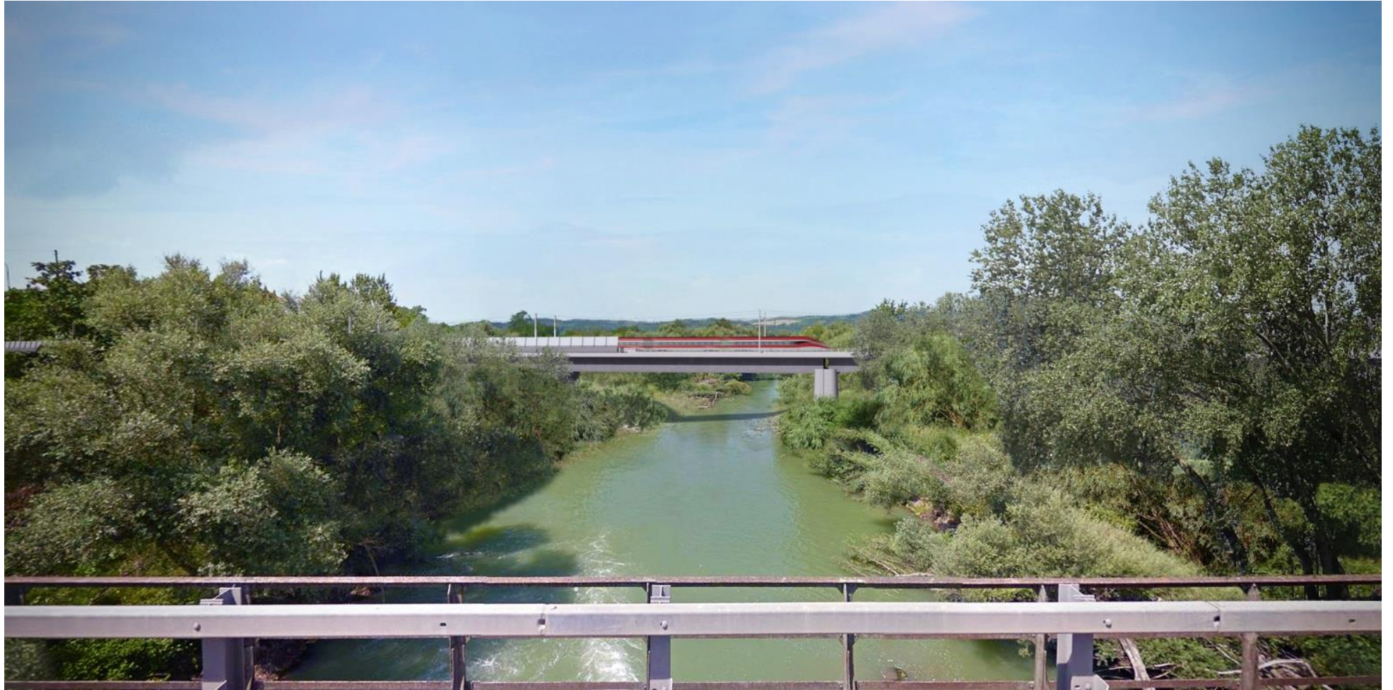
Figura 11 – Fase 3 (Post-operam), con interventi di mitigazione, WBS VI05
