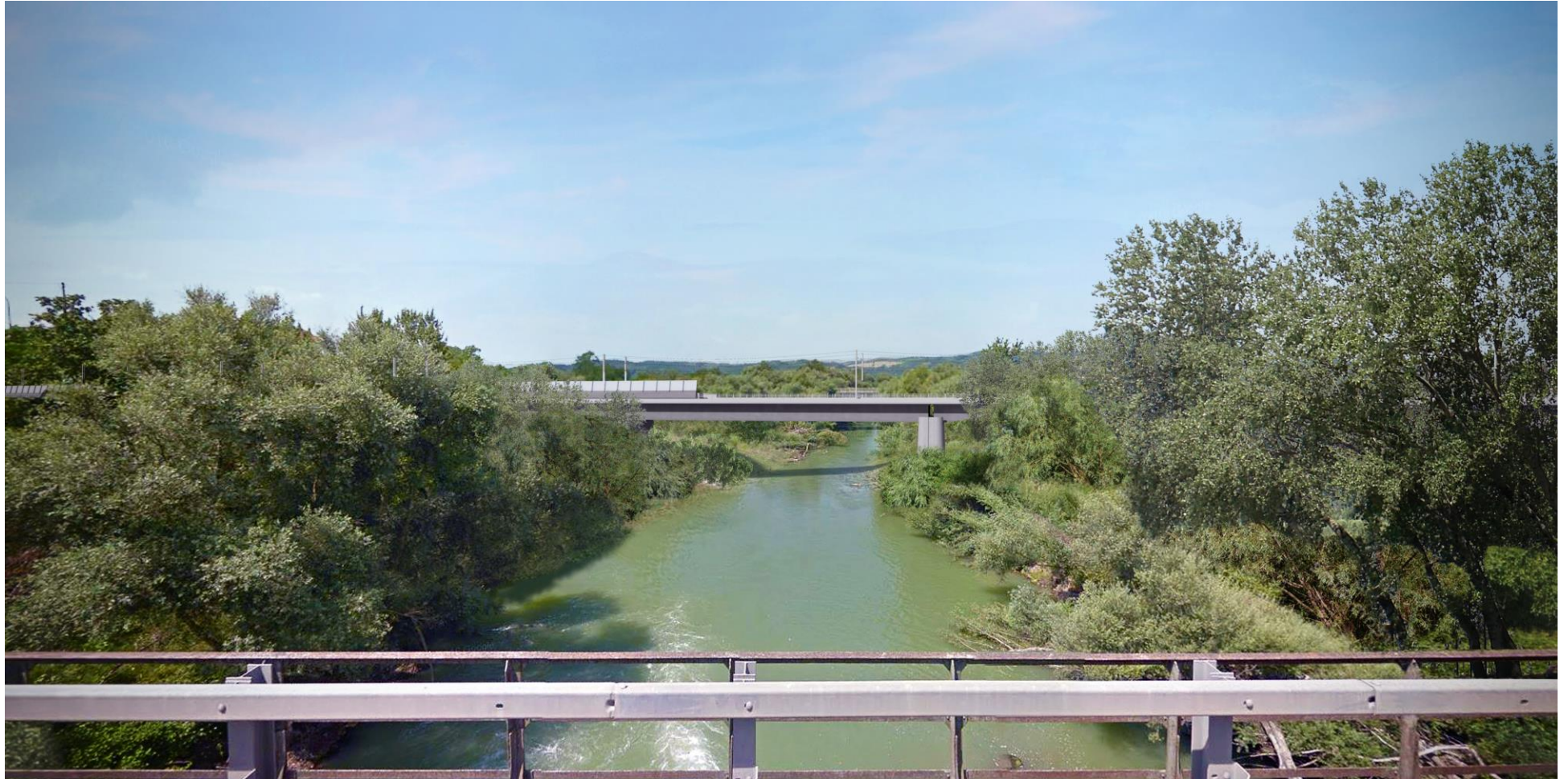
Figura 10 – Fase 2 (Post-operam), con interventi di mitigazione, WBS VI05
