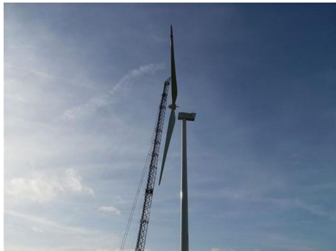
Figura 3 - Fasi di montaggio aerogeneratori (per concessione di Gamesa Italia S.p.a.).
