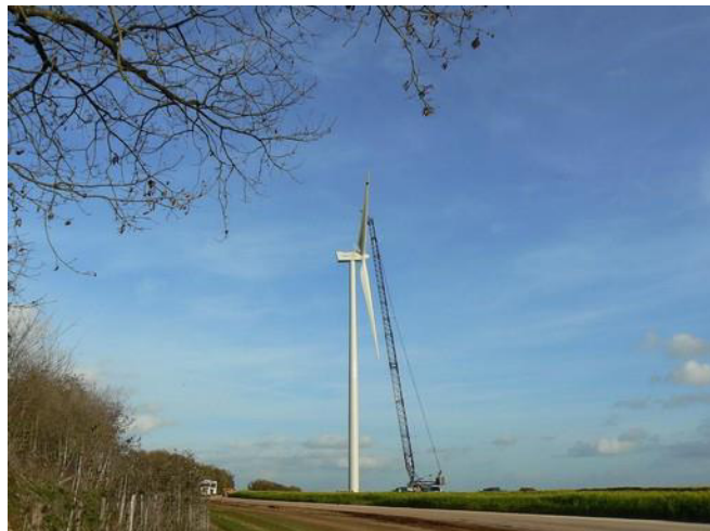
Figura 3 - Fasi di montaggio aerogeneratori (per concessione di Gamesa Italia S.p.a.).
