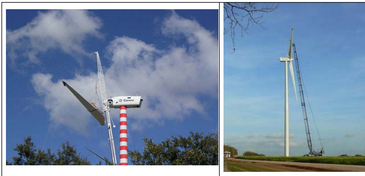
Figura 2.7 – Immagini trasporto componenti e montaggio aerogeneratore (fonte: Elaborati Gamesa Energia Italia S.p.A.)
