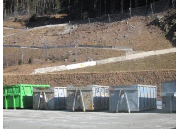
Baustelle Muls / Cantiere di Mules
