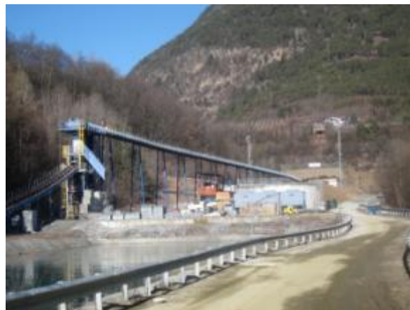
Baustellenareal - Area di cantiere
