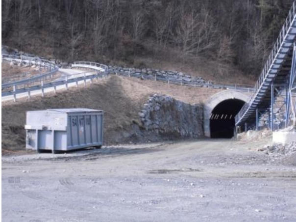
Baustelle Hinterrigger/ Cantiere di Hinterrigger
