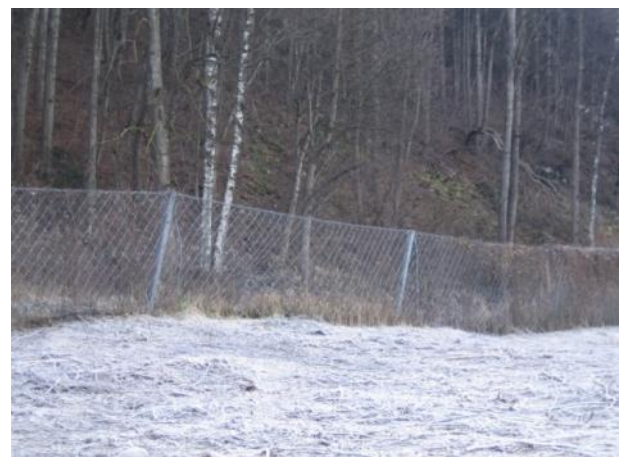
Funzionale delimitazione di protezione della fascia alla base del versante
