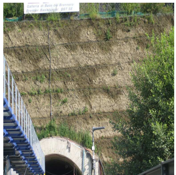
Terre armate sopra il portale della galleria Aica - Mules
