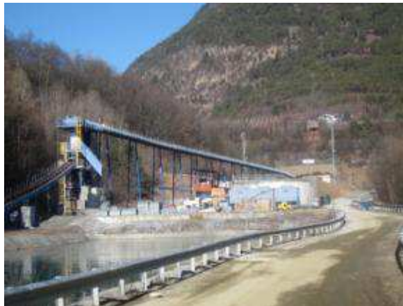
Baustellenareal - Area di cantiere
