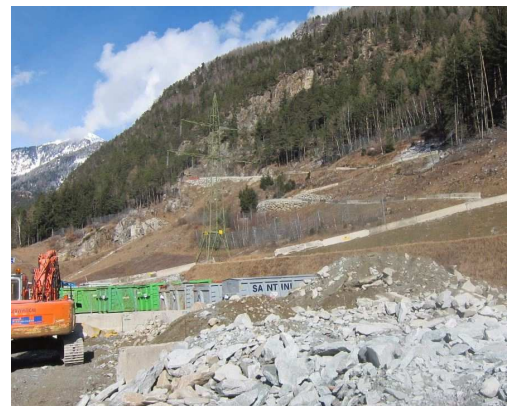
Baustelle Mauls / Cantiere di Mules
