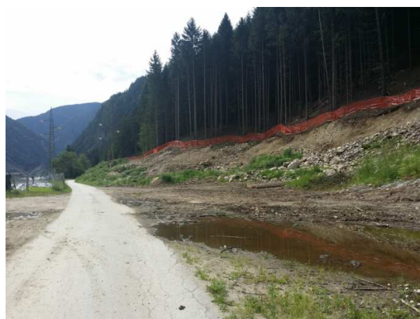
Fällungsarbeiten längs des Hanges - Taglio arboreo lungo il versante
