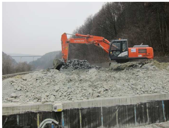
Vasche dei fanghi dell'impianto di depurazione
