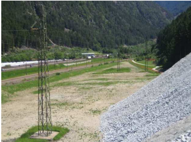
Baustelle - Area di cantiere
