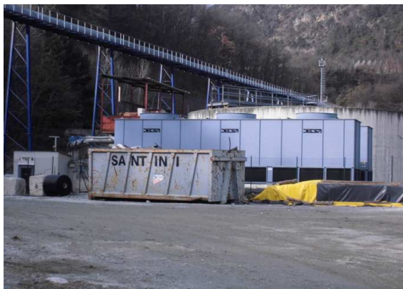
Baustelle Hinterrigger/ Cantiere di Unterplattner
