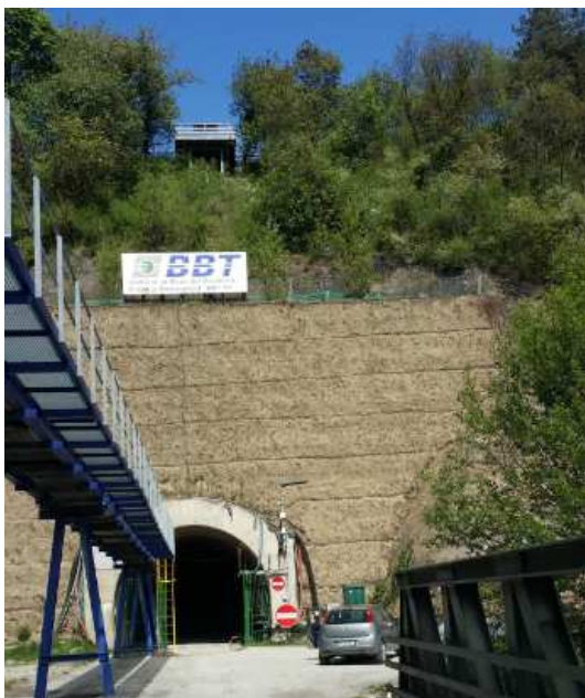
Terre armate sopra il portale della galleria Aica - Mules
