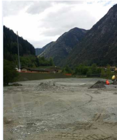
Basislager Franzenfeste - Campo base Fortezza
