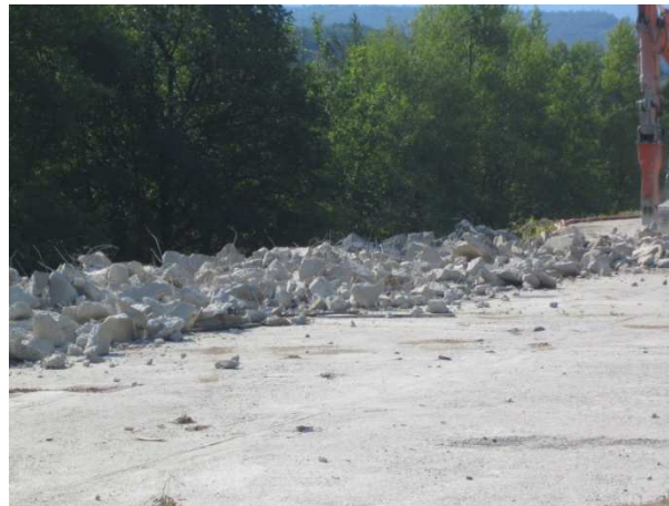
Demolizione fondazioni pregresse
