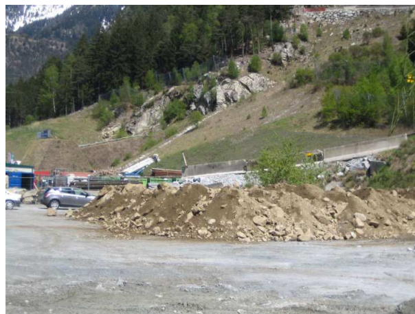
Baustellenplatz Muls 2 ohne Aushubmaterial
