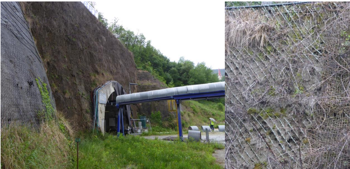
Figura 8: portale di Aicha e particolare della rete di tipo Krismer
