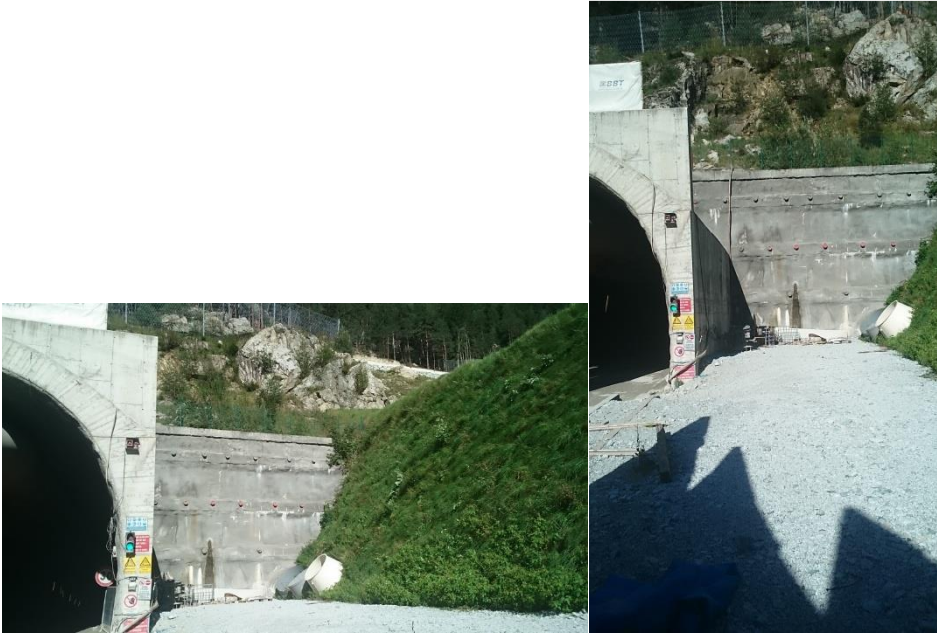
Figura 2: portale di Mules; in evidenza la berlinese cui si deve garantire l'accesso fino al termine dei lavori
