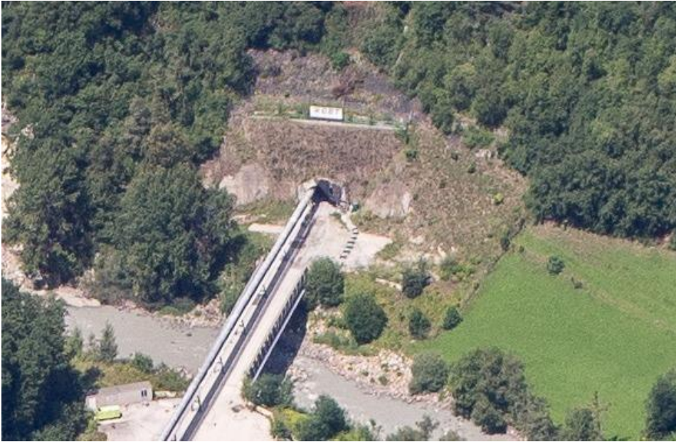
Figura 7: visione d'insieme del portale di Aica; è possibile notare che su ampie superfici delle scarpate laterali appare il rivestimento in calcestruzzo proiettato che doveva essere ricoperto da inerbimento e la parete centrale con vegetazione stentata o seccata
