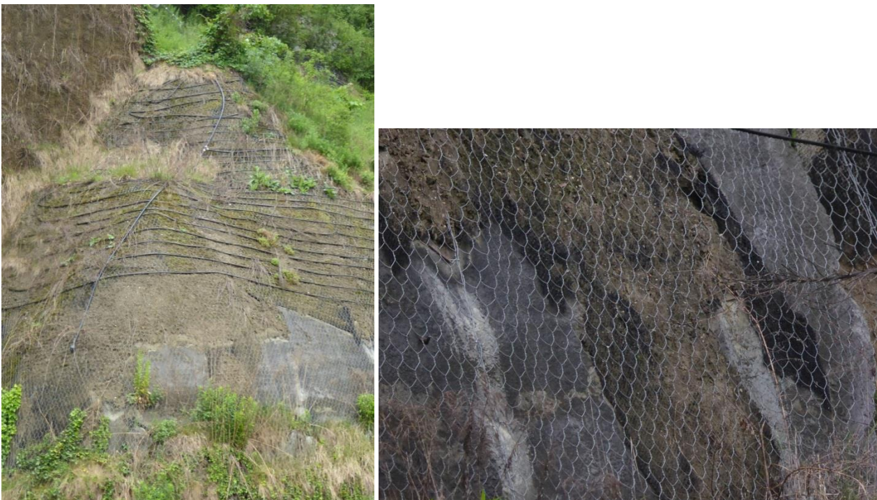
Figura 9: scarpata adiacente l'ingresso del tunnel, rivestita in calcestruzzo proiettato e geostuoia con sovrapposta rete metallica a maglia esagonale
