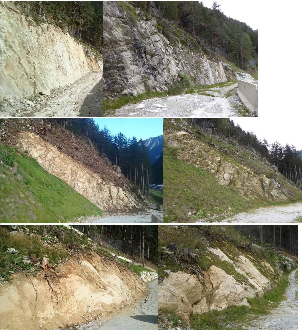
Figura 16: scarpate in roccia, a sinistra prima dell'utilizzo, a destra settembre 2017
