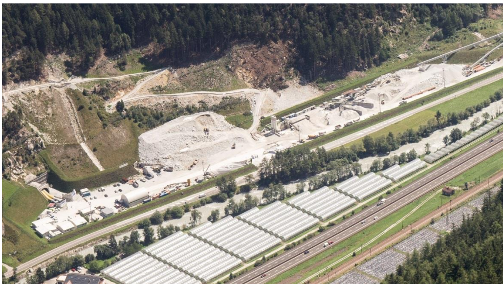
Figura 1: vista d'insieme del cantiere di Mules a settembre 2014; è possibile notare le problematiche principali: le opere in muratura del portale, le scarpate detritiche della strada di servizio, il versante privo di vegetazione arbustiva e arborea, i rilevati che circondano il cantiere di forma rigidamente geometrica (foto fornita da BBT)
