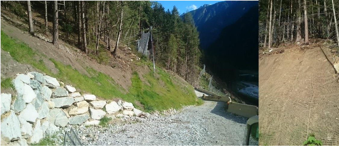
Figura 3: consolidamento e copertura della scarpata di monte della strada di servizio
