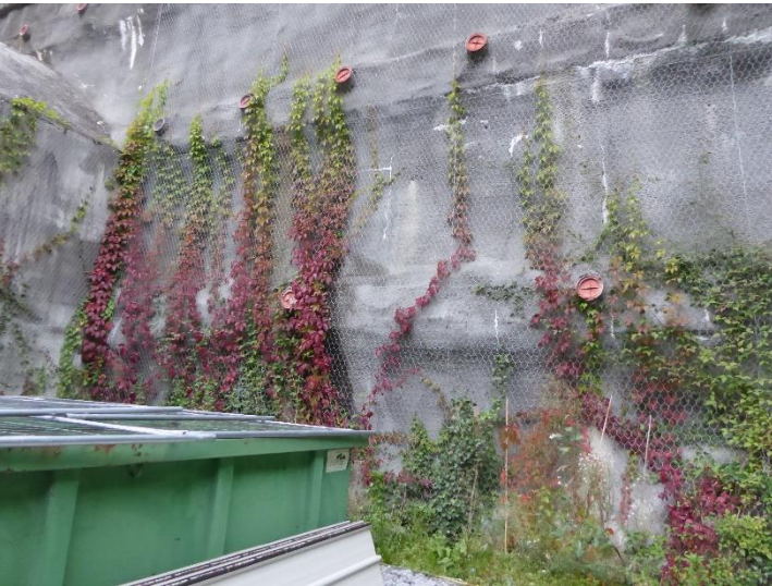
Figura 20: portale di Mules prima dell'intervento e a settembre 2017
