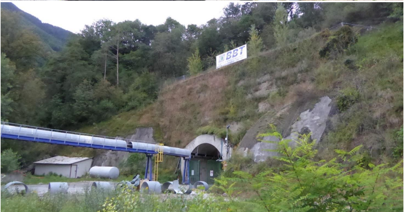
Figura 22: portale di Aica prima dell'intervento e a settembre 2017
