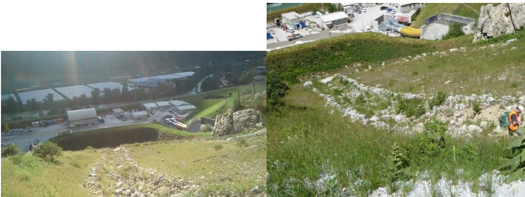
Figura 6: versante sovrastante l'area adiacente il portale con impluvio parzialmente regimato e relativo versante
