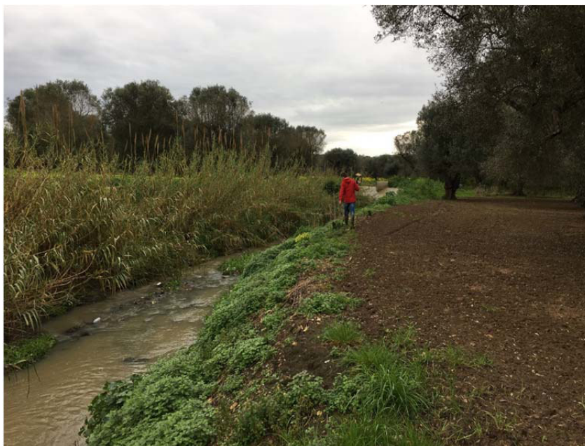
Fig.3.3/B: Canale Infocaciucci, zona dell'attraversamento del metanodotto Int. TAP DN 1400 (56'')
