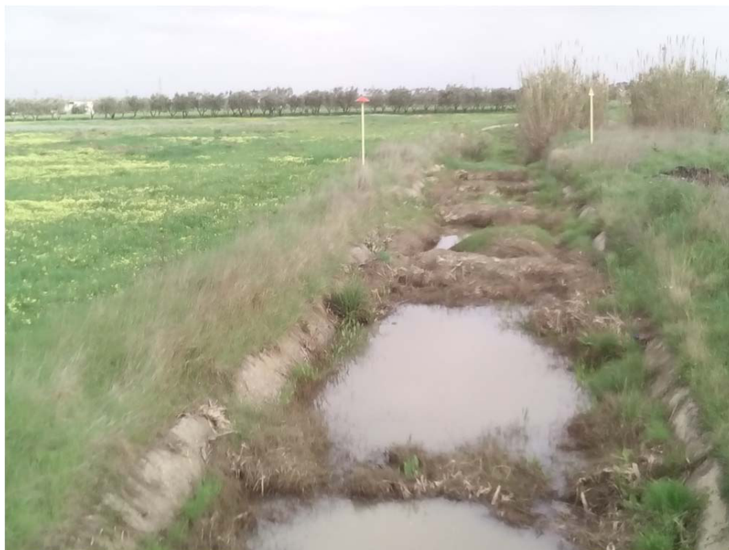
Fig.2.2/A: Canale Cillarese, zona dell'attraversamento del metanodotto Int. TAP DN 1400 (56")
