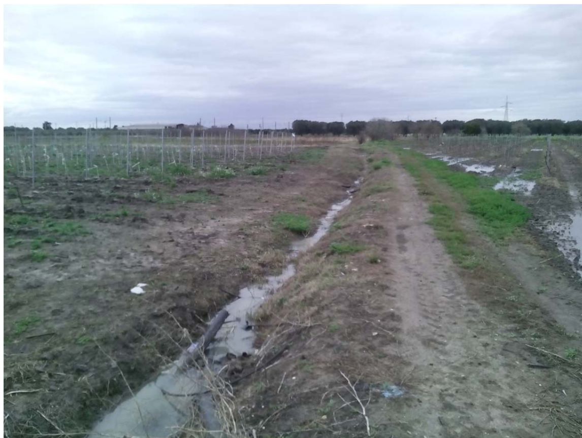
Fig.2.2/A: Canale Episidico 2, zona dell'attraversamento del metanodotto Int. TAP DN 1400 (56")
