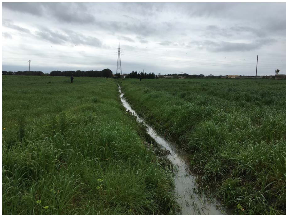
Fig.2.2/A: Canale Episodico 4, zona dell'attraversamento del metanodotto Int. TAP DN 1400 (56'')
