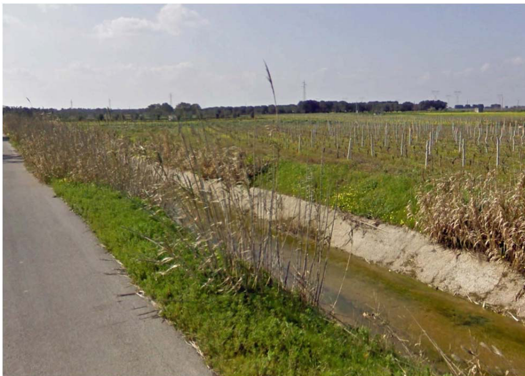
Fig. 3.3/A: foto dell'area di attraversamento.
