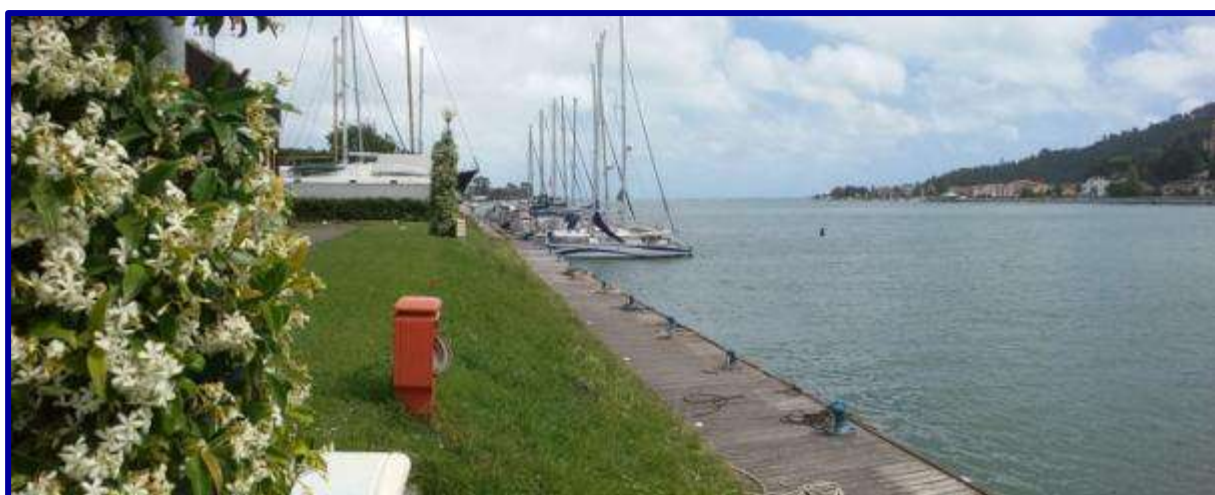
Foto 24 - Vista della banchina di ormeggio (punto di vista verso Bocca di Magra)
