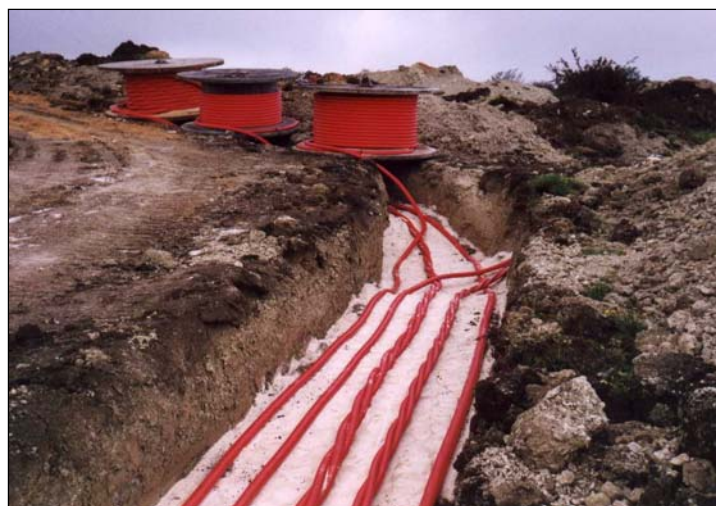
Particolare posa cavi elettrici.
