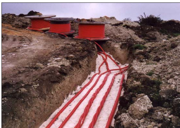
Particolare posa cavi elettrici.
