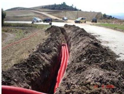
Fig. 1.2 - Foto illustrativa della messa in posa dei cavidotti MT
