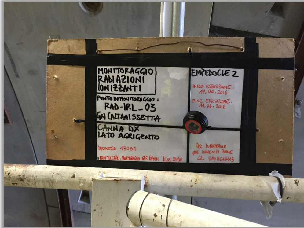
Dosimetro installato all'interno della GN Caltanissetta – canna dx durante lo scavo meccanizzato della TBM
