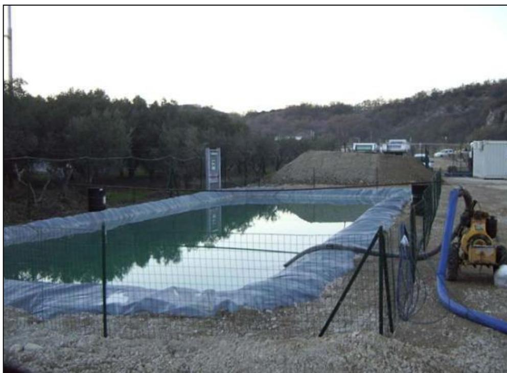
**Figura 4.6: Vascone per lo Stoccaggio in Cantiere dell'Acqua Industriale**
