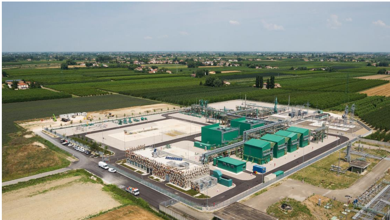
Figura 4.3: Edison Stoccaggio - Centrale di Stoccaggio San Potito e Cotignola
