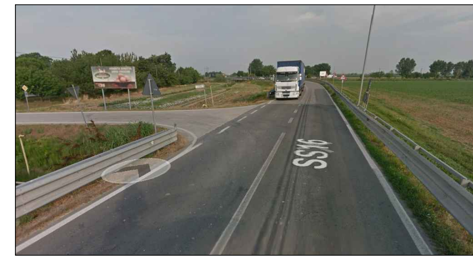
FOTO 1: INNESTO ESISTENTE TRA SS-16 E SP-69
