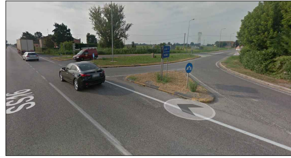
FOTO 3: INNESTO ESISTENTE TRA SS-16 E SP-39
