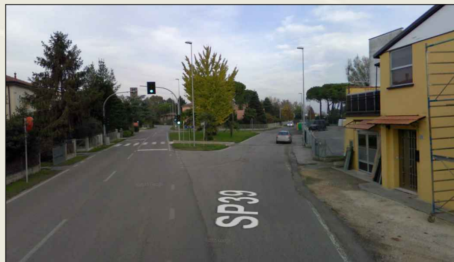
FOTO 5: INNESTO ESISTENTE TRA Sp-39 E SC VIA FIUMAZZO
