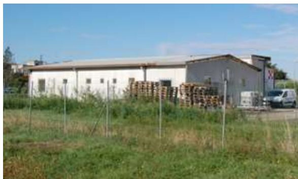
Figura 31 - Edificio Catering Aviazione Commerciale
