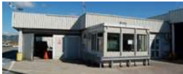
Figura 24 – Pensilina mezzi di rampa, U.S.M.A.F./Sanità aerea, spogliatoio addetti
