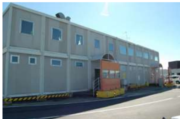
Figura 25 – OUA e CORAMP, uffici, spogliatoio e rest room
