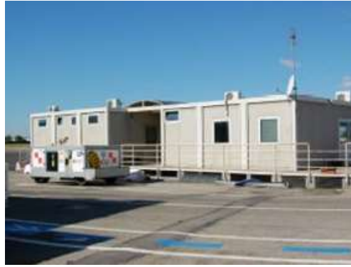
Figura 26 – Uffici AEROCUB, uffici, magazzini mezzi di rampa
