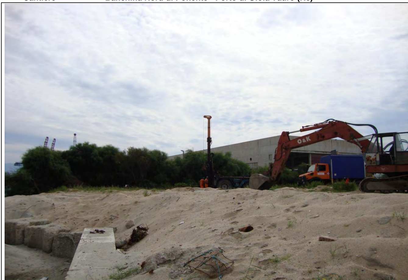
SONDAGGIO S4_BNP- POSTAZIONE
