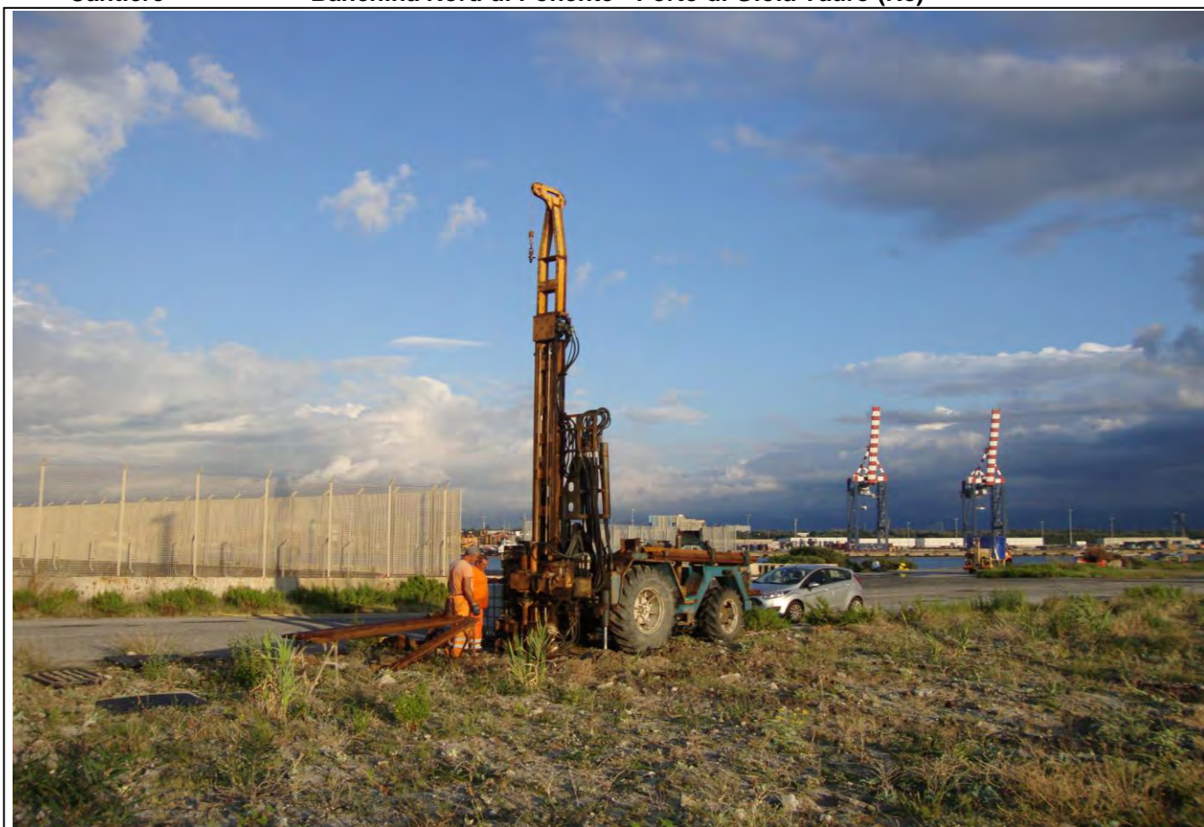
SONDAGGIO S6_BNP- POSTAZIONE
