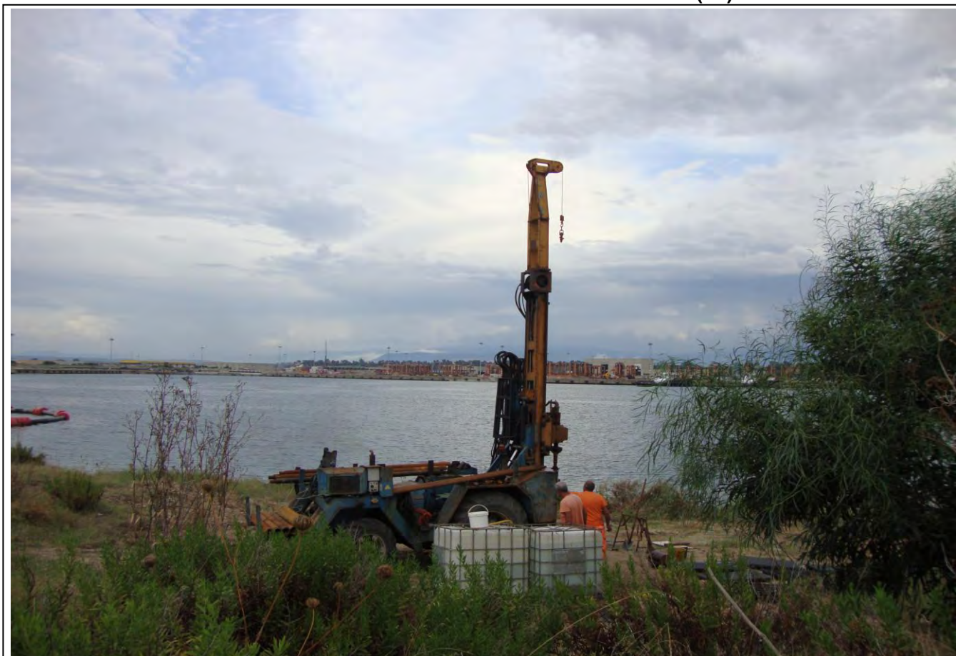
SONDAGGIO S3_BNP- POSTAZIONE
