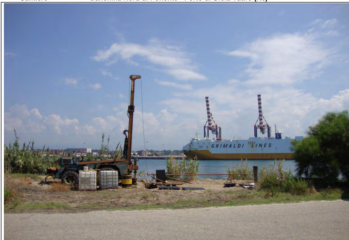
SONDAGGIO S2_BNP- POSTAZIONE
