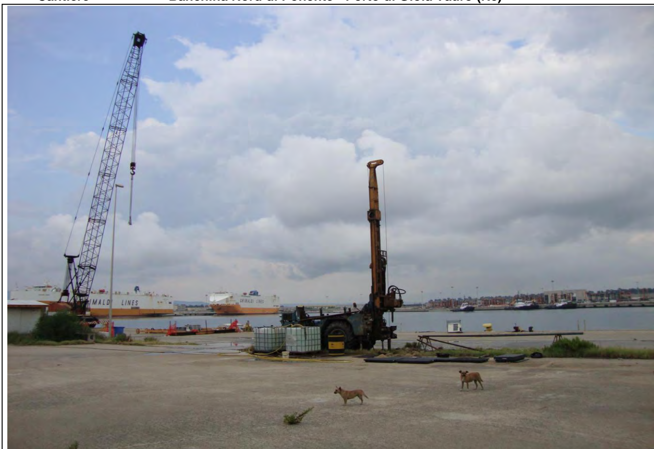
SONDAGGIO S1_BNP- POSTAZIONE
