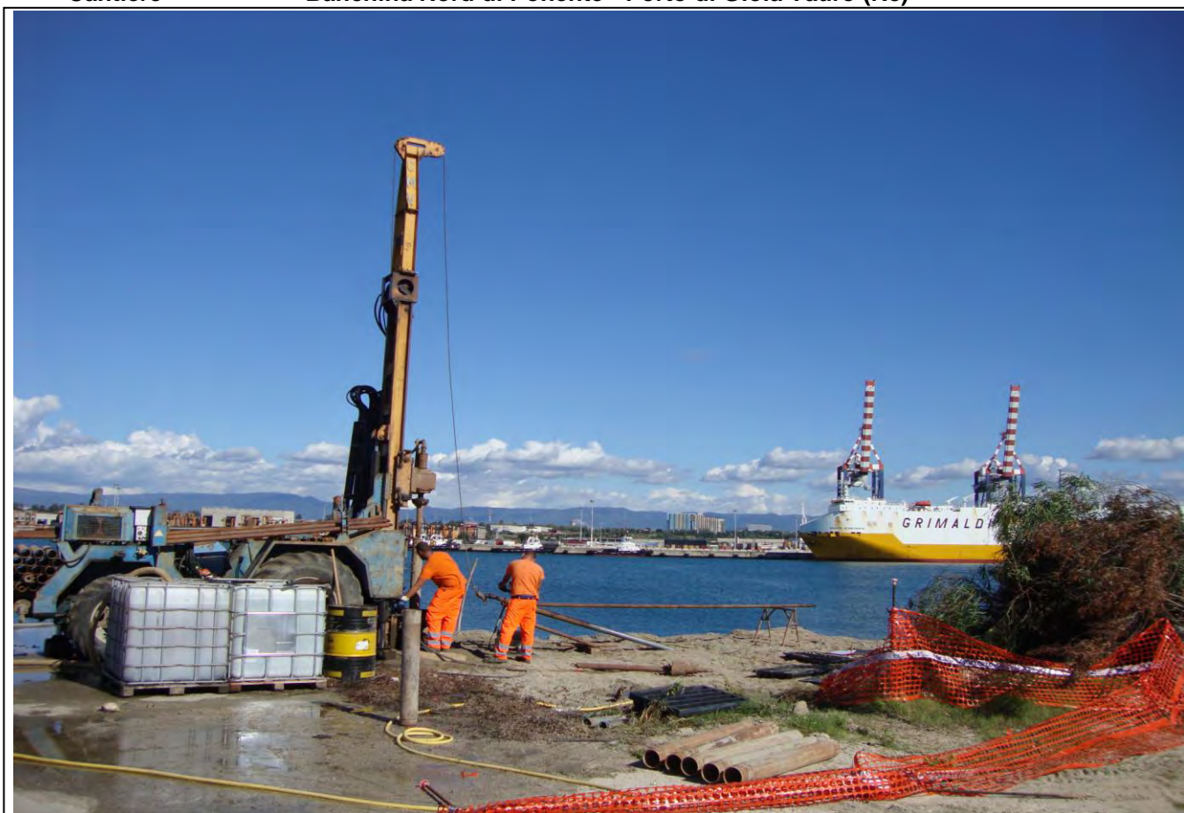
SONDAGGIO S5_BNP- POSTAZIONE
