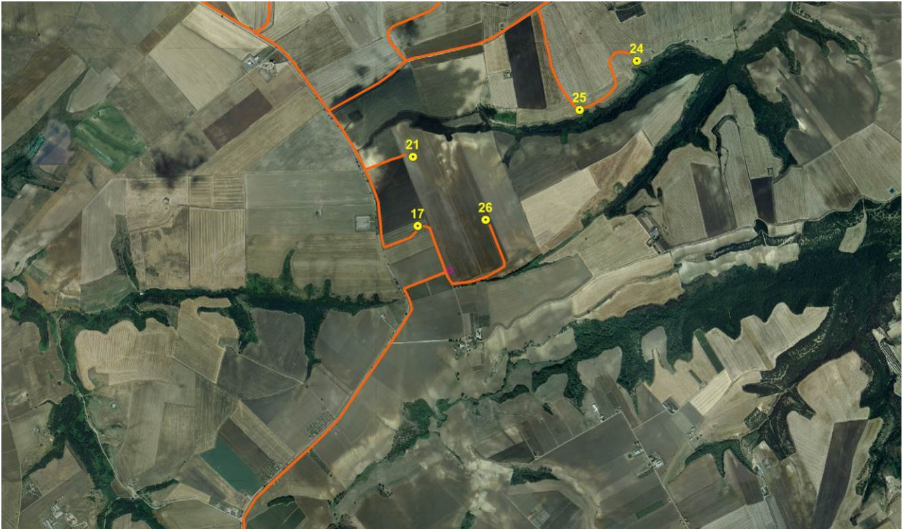
Fig.18a, 18b, 18c: Stralci di ortofoto (2013) dell'impianto eolico in esame; in giallo la numerazione delle turbine, in arancione i tracciati di cavidotto interrato.
