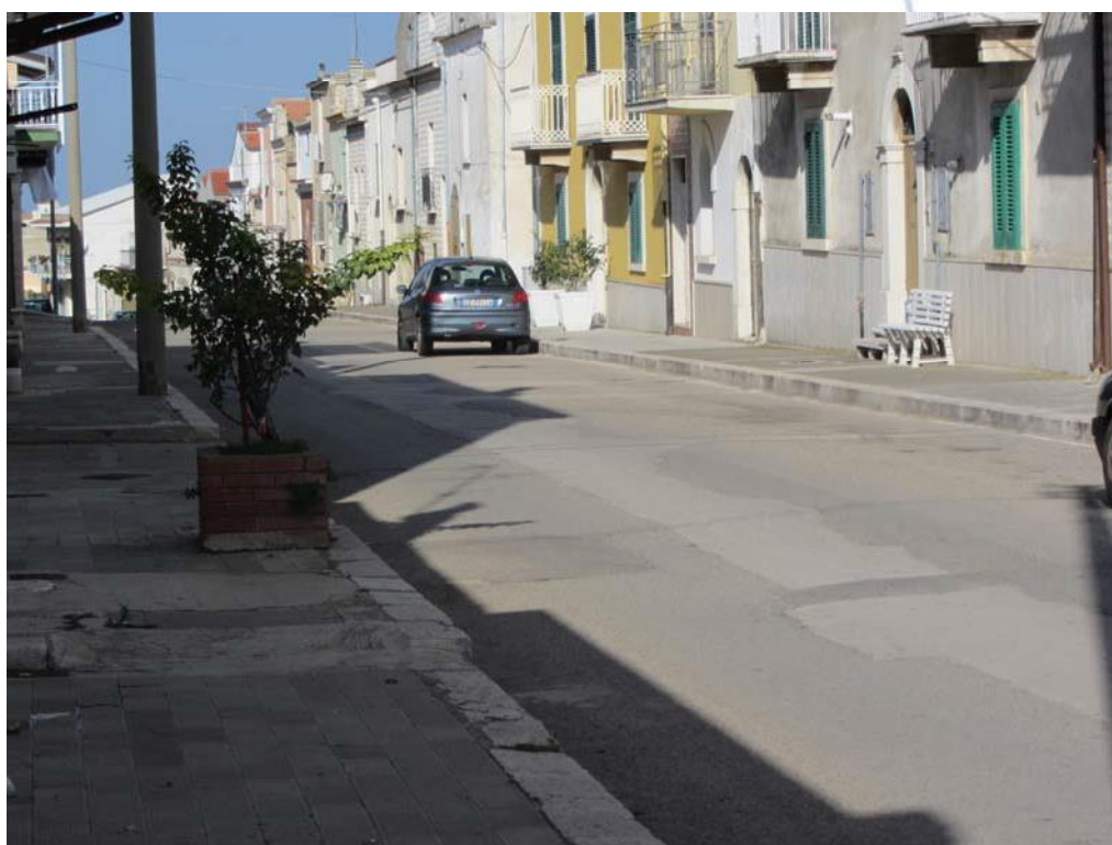
Fig. 5 – asfalto da sostituire con pavimentazione di basole in pietra locale lungo Viale Elena-Via XXIV Maggio
