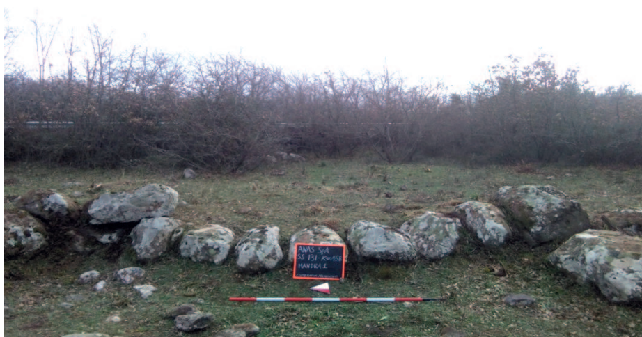
Foto 23. Mandra 1 , vista da Ovest
