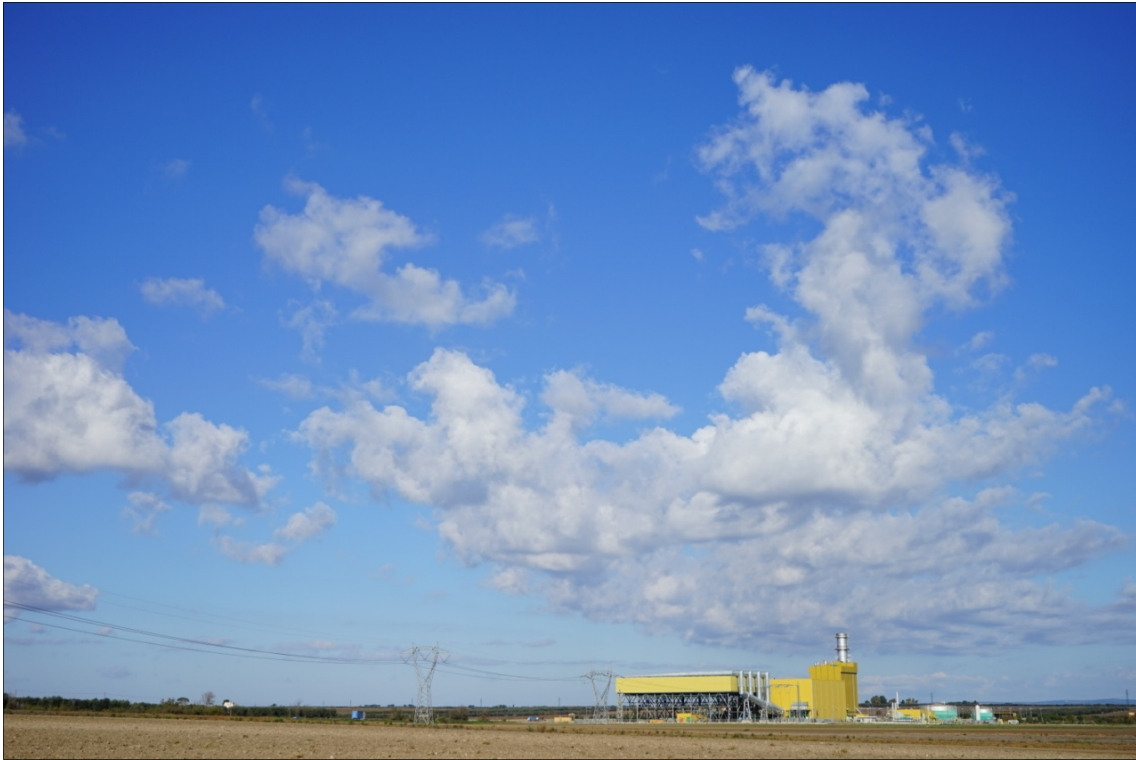
Fig. 1. Località Ratino, San Severo. Centrale Enplus.
