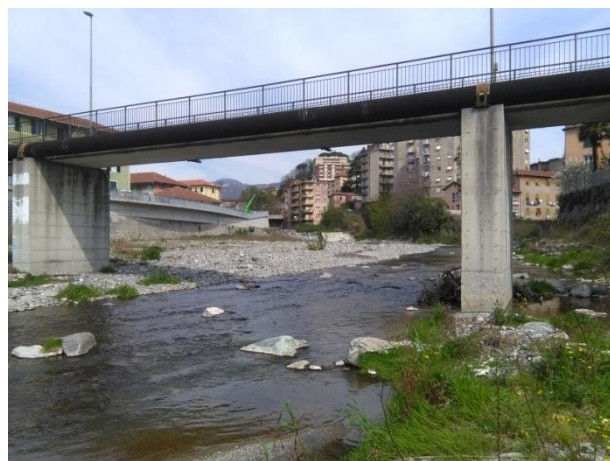
Foto della stazione verso monte
