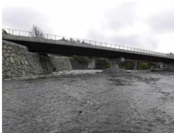
Foto della stazione verso monte
