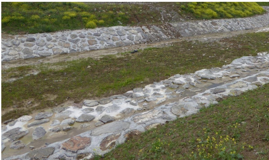
Figura 3: panoramica stazione di rilievo VEG-AR-500B
