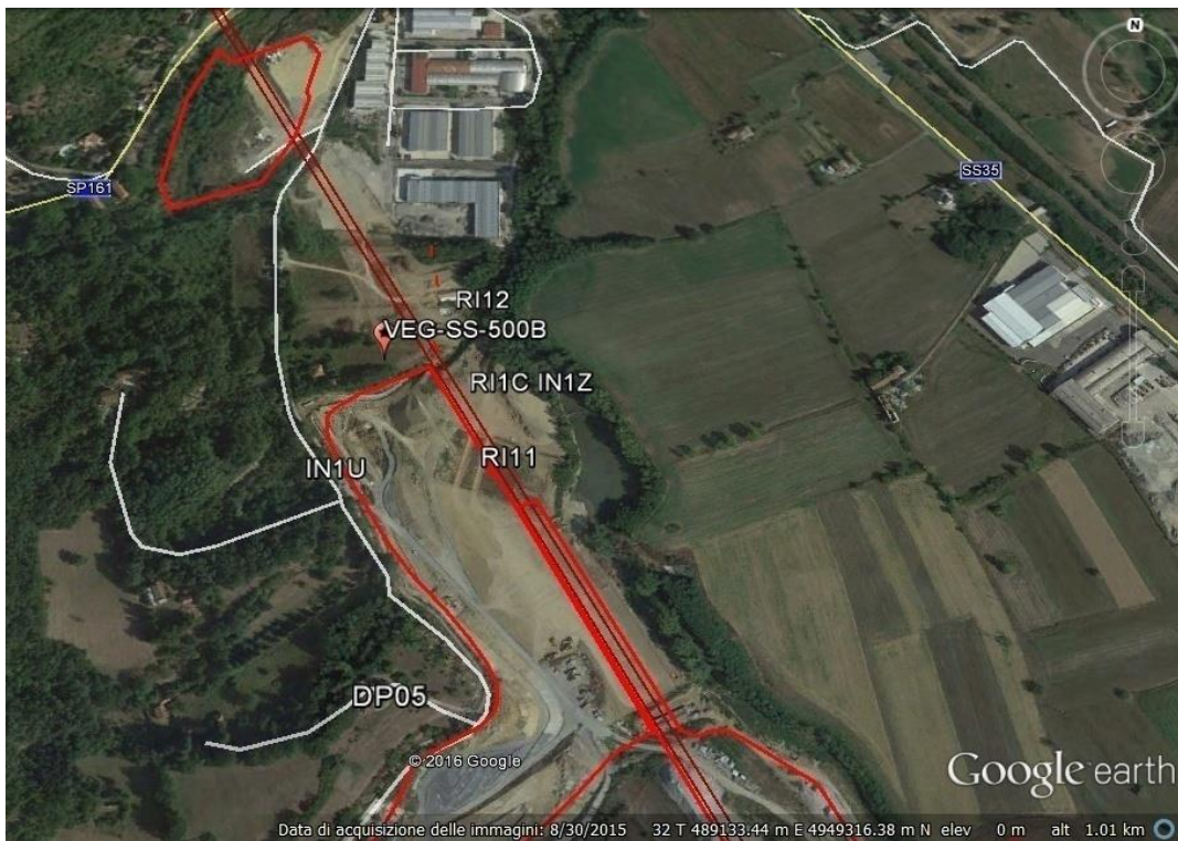
Figura 5.15.2: localizzazione stazione di rilievo VEG-SS-500B
