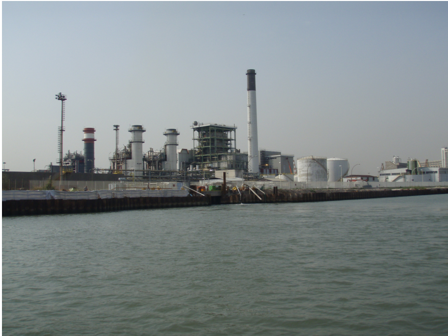
Foto 1 – Vista della Centrale di Levante in corrispondenza del punto di scarico
