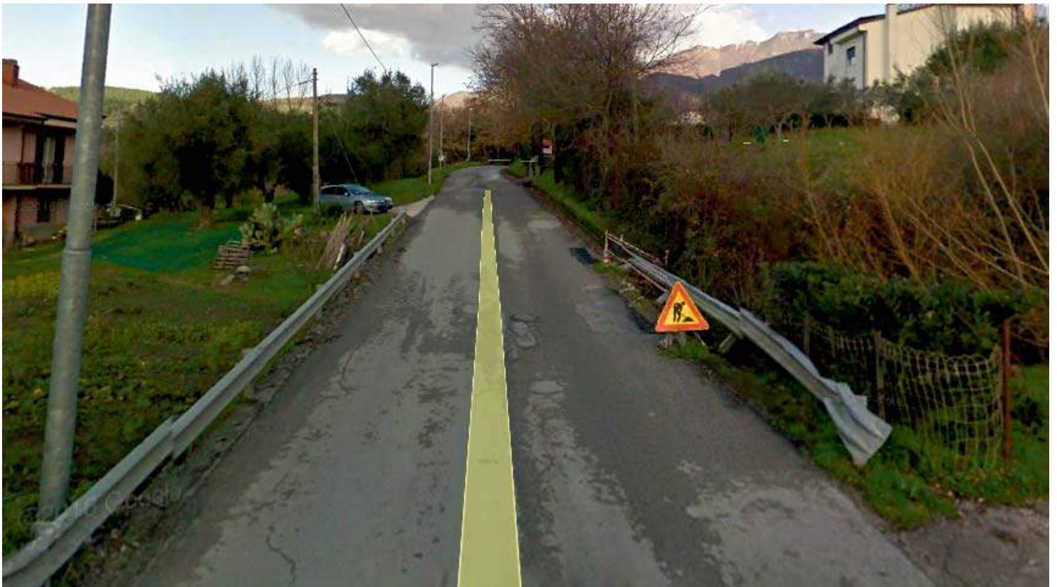
FOTO 2 (TRATTO C D)
