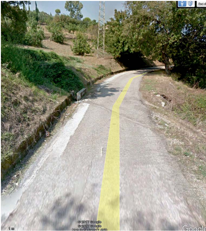
foto 1 - immagine da Google della sede stradale in corrispondenza di un attraversamento di un modesto impluvio
