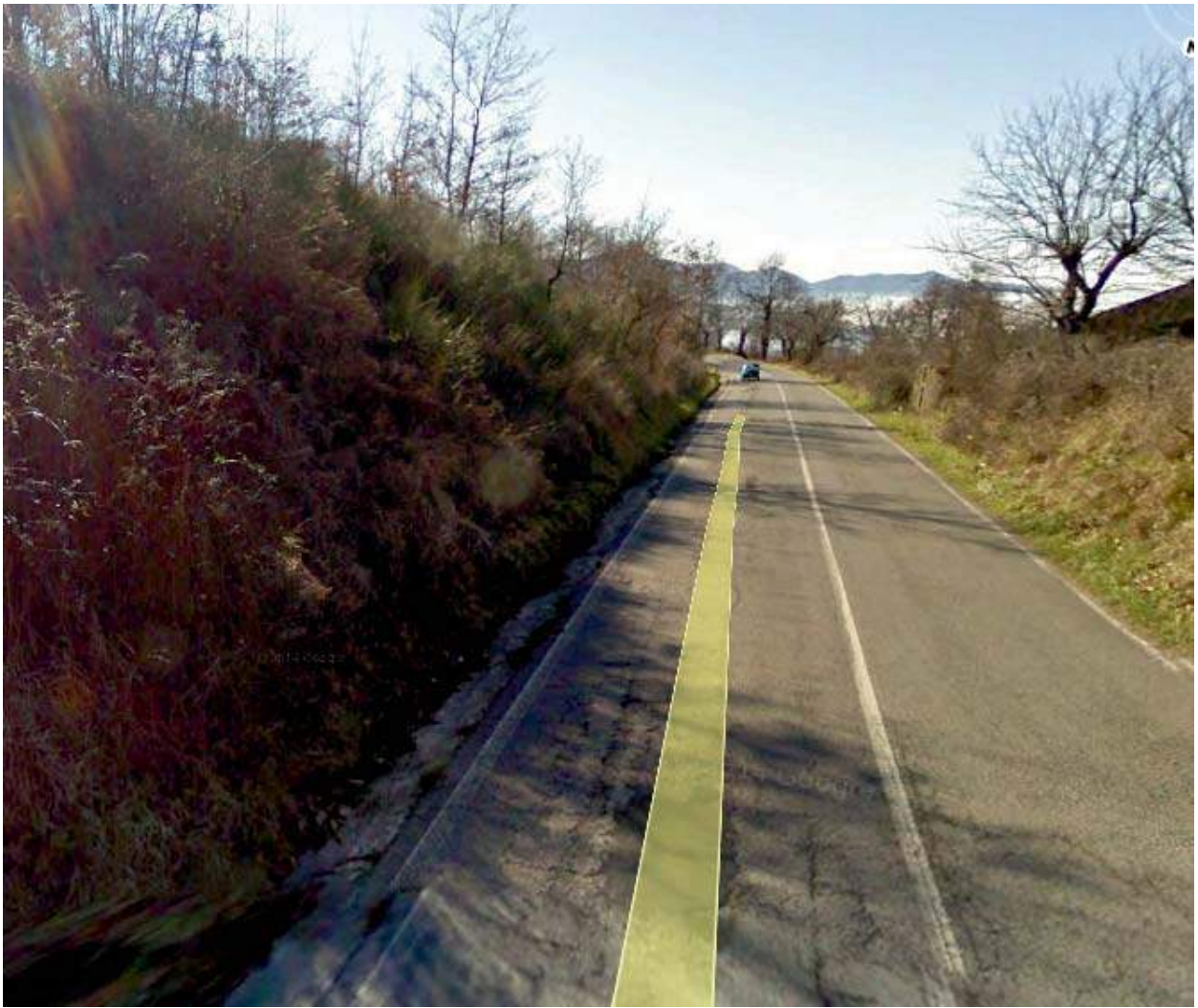
FOTO 6 (TRATTO B C - PUNTO C)
