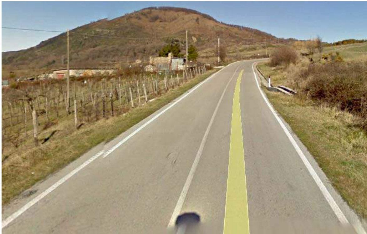
FOTO 7 (TRATTO D E - PUNTO D)
