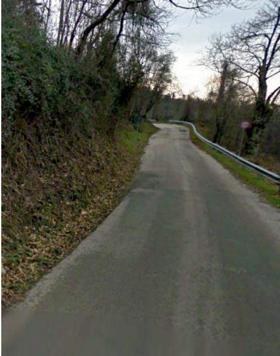
FOTO 5 TRATTO D E
