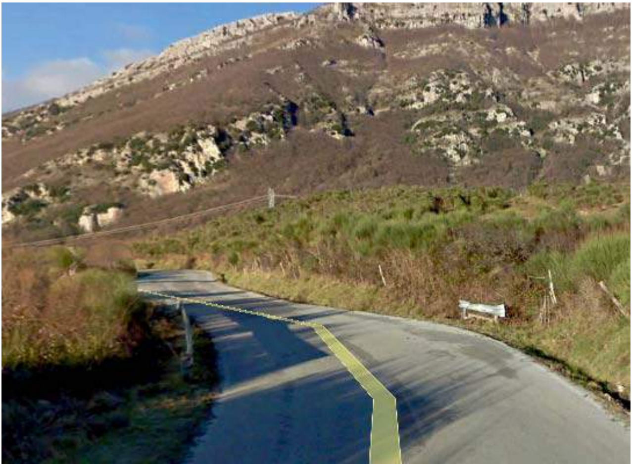
FOTO 5 TRATTO C D
