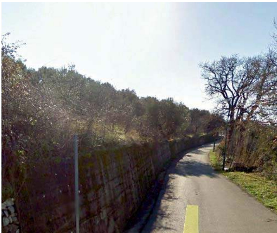
FOTO 4 (TRATTO C E - prossimità del punto E )
