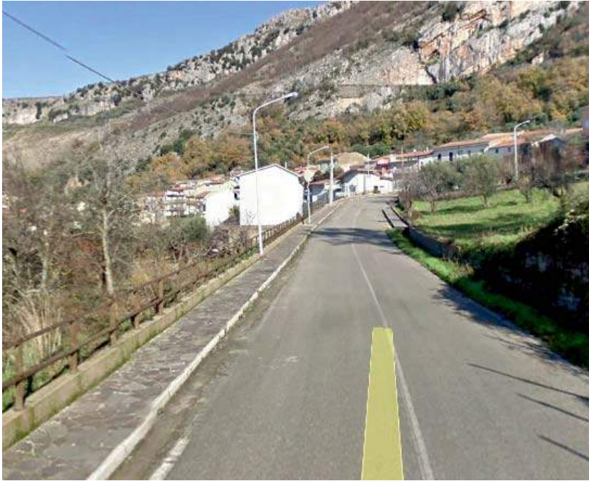
FOTO 5 TRATTO A B
