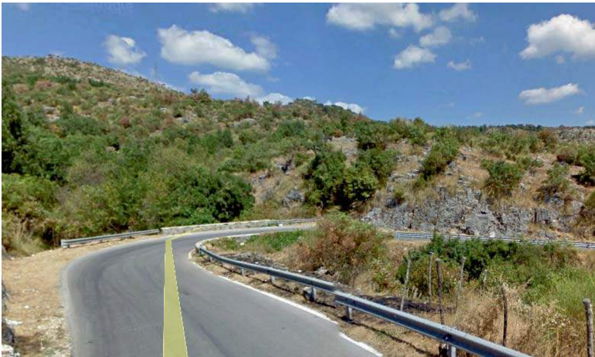
FOTO 6 TRATTO D E
