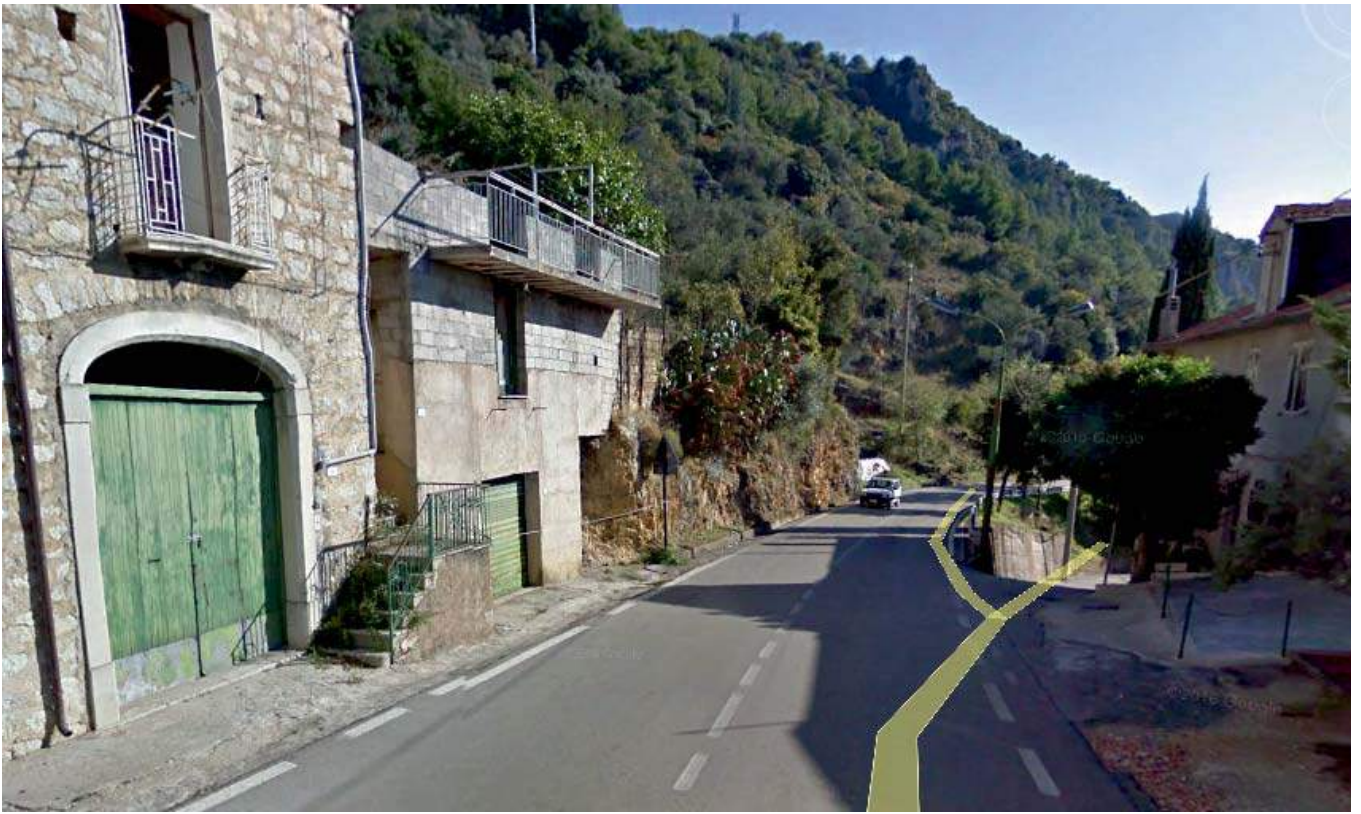
FOTO 5 TRATTO D E
