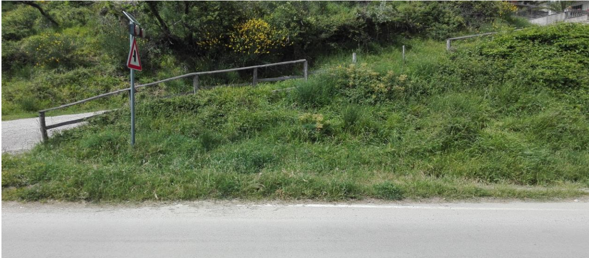
Piaggine – Posizione Gruppo di Riduzione – GRF - Prima
