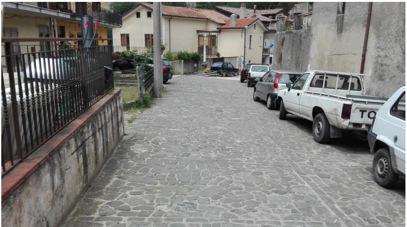
Strade – Pietra locale – basaltica
