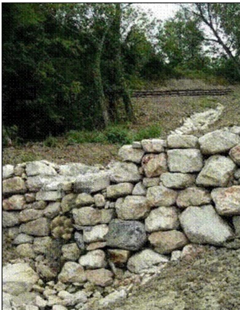
Secondo l'orografia del terreno, la briglia potrà essere di una misura, nel senso di scorrimento dell'acqua, tale da consentire il guado di un veicolo per la successiva ispezione del tracciato e l'eventuale manutenzione dell'impianto.
