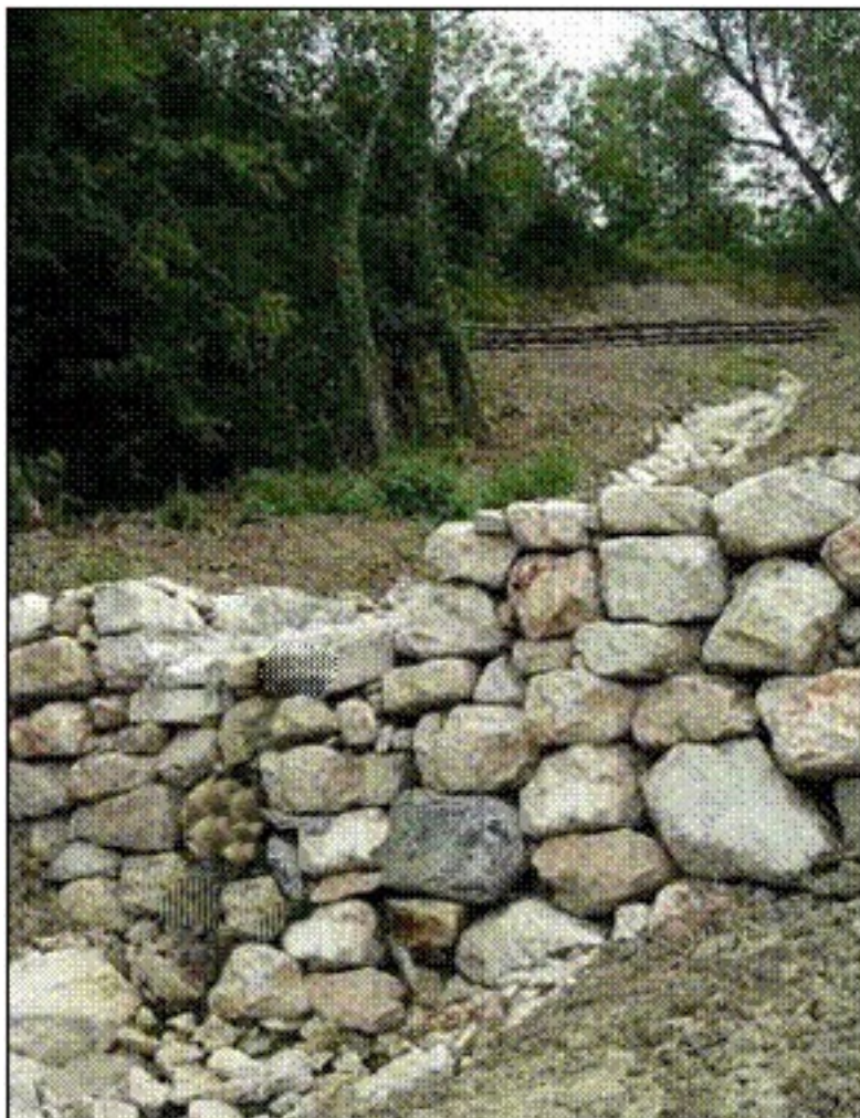
Esempio di briglia in pietra viva su linea di impluvio
