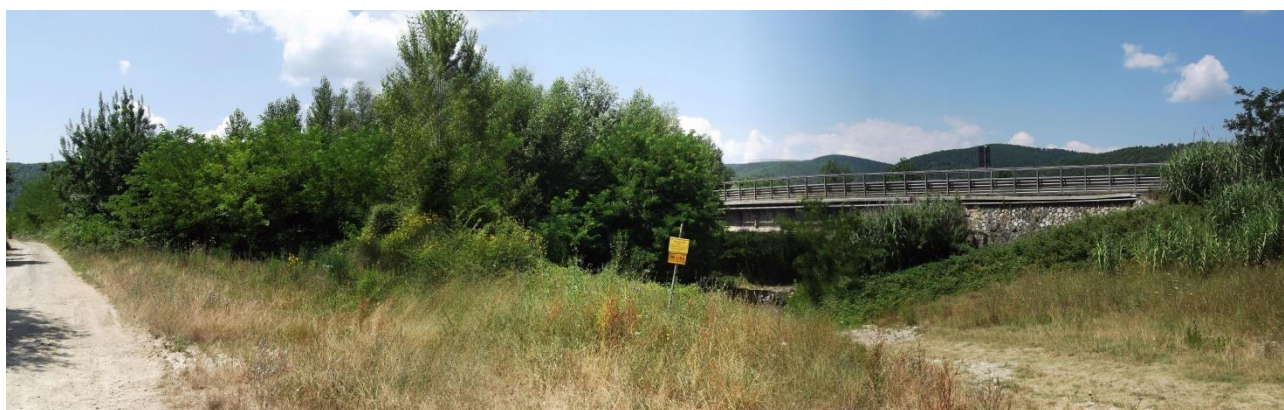
Figura 4-65 Visuale del viadotto Merse da strada interpodereale (foto A6)
