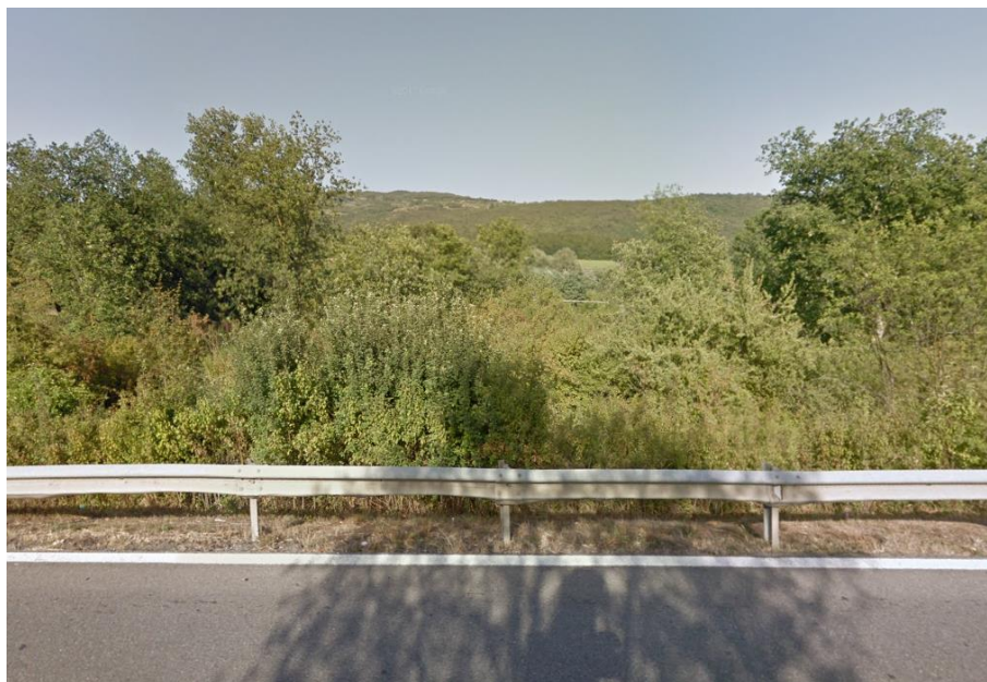
Figura 4-68 Visuale dell'opera di protezione spondale (circa Prog 44+400-44+600) dalla E78 (foto A8)
