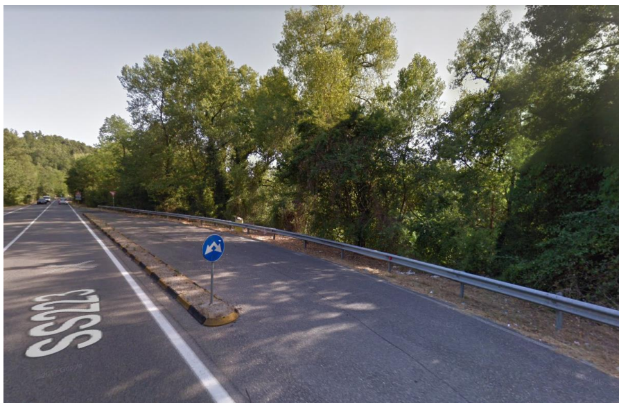
Figura 4-70 Visuale dell'opera di protezione spondale (circa Prog 50+200-50+350) dalla E78 (foto A9)
