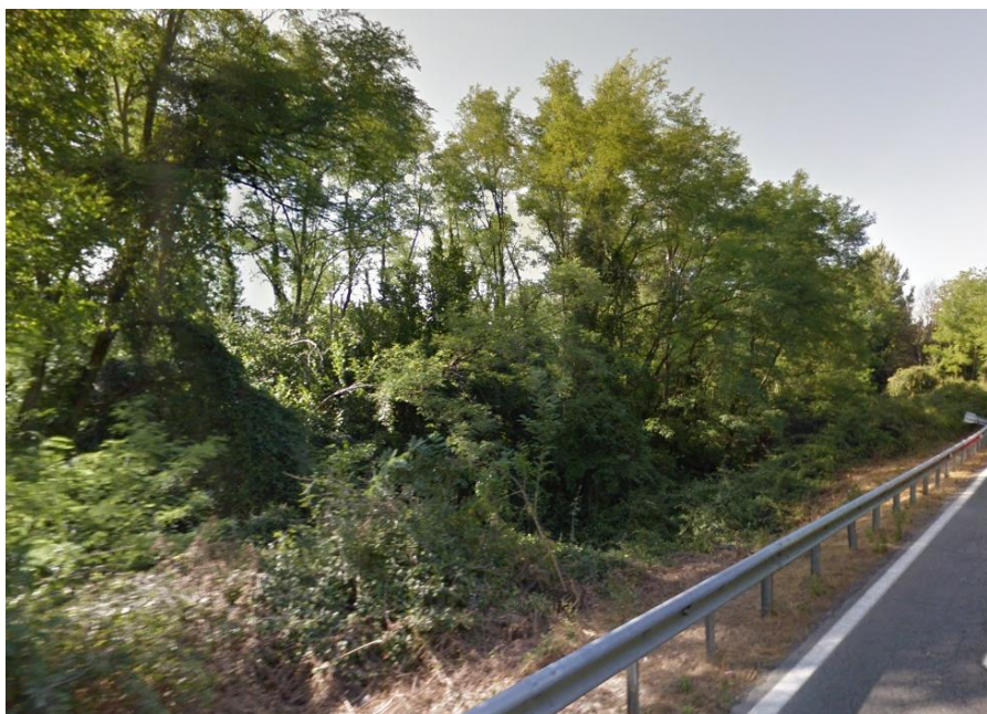
Figura 4-71 Visuale dell'opera di protezione spondale (circa Prog 50+200-50+350) dalla E78 (foto A10)
