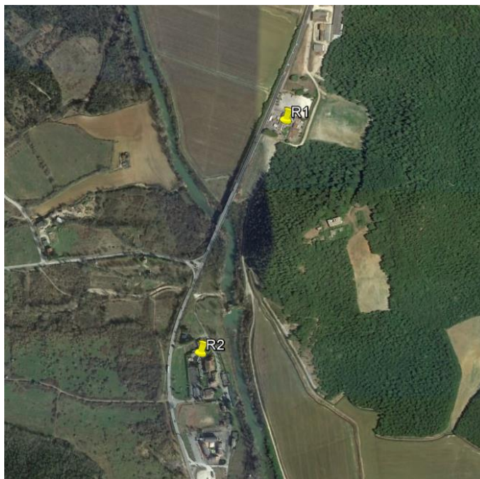
Figura 4-103 Localizzazione ricettori in prossimità del cantiere per la realizzazione del viadotto sul Fiume Merse
