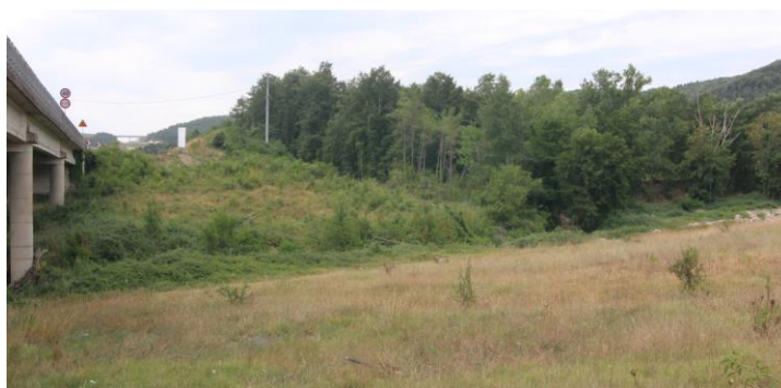
Figura 4-45 Vegetazione a ovest del viadotto
