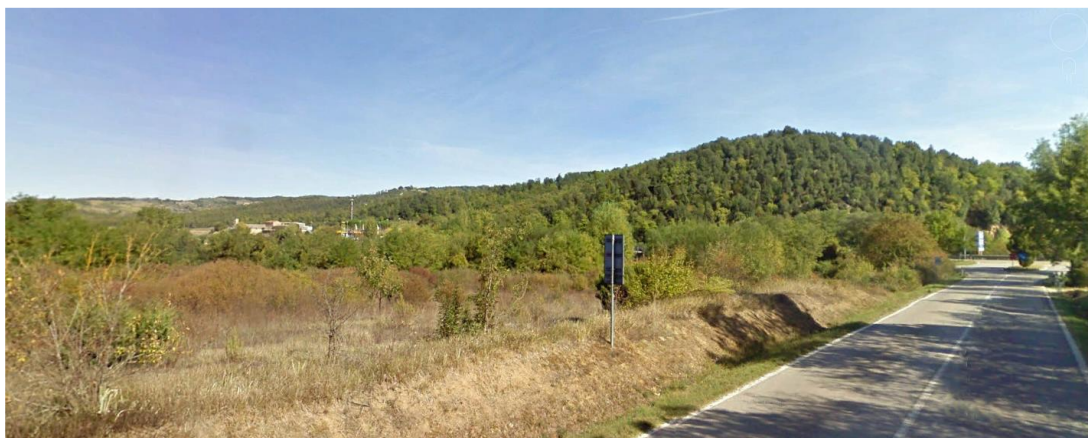
Figura 4-63 La vista dalla S.P.32 verso il viadotto sul Merse schermata dalla presenza di vegetazione che ostacola la percezione dell'opera (foto A4)
