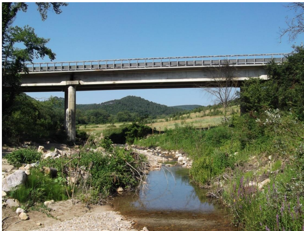
Figura 4-58 Viadotto sul fiume Ornate
