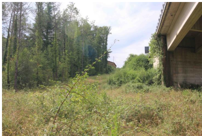
Figura 4-43 Vegetazione presente a ridosso dell'area di cantiere n. 1 PD2016 in corrispondenza della spalla sud esistente
