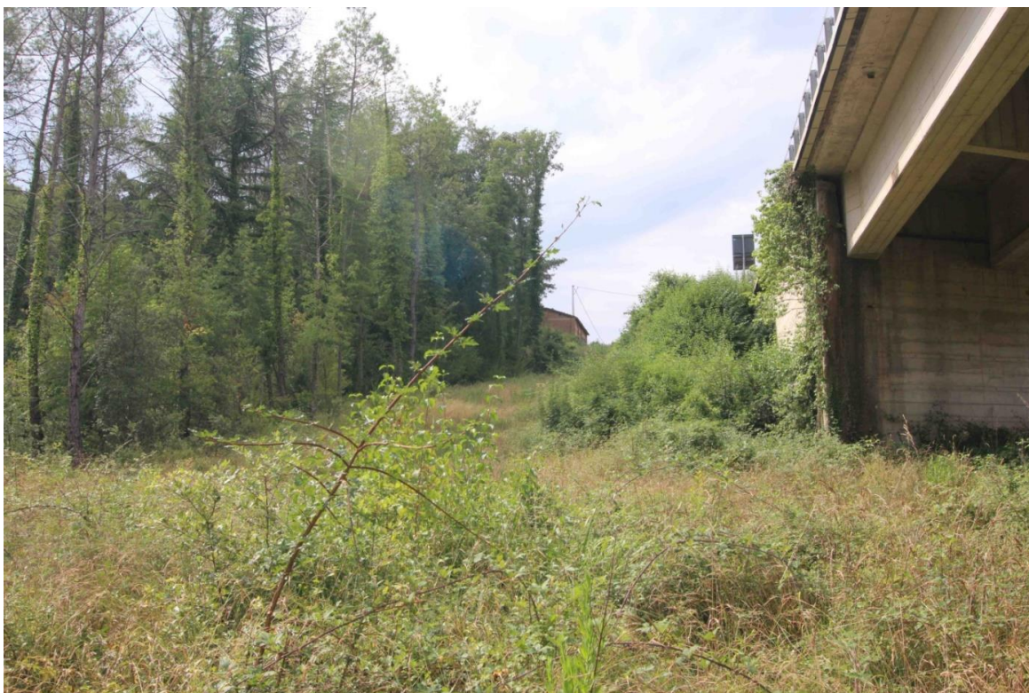
Figura 10.2 Vegetazione presente a ridosso dell'area di cantiere n. 1 PD2016 in corrispondenza della spalla sud esistente
