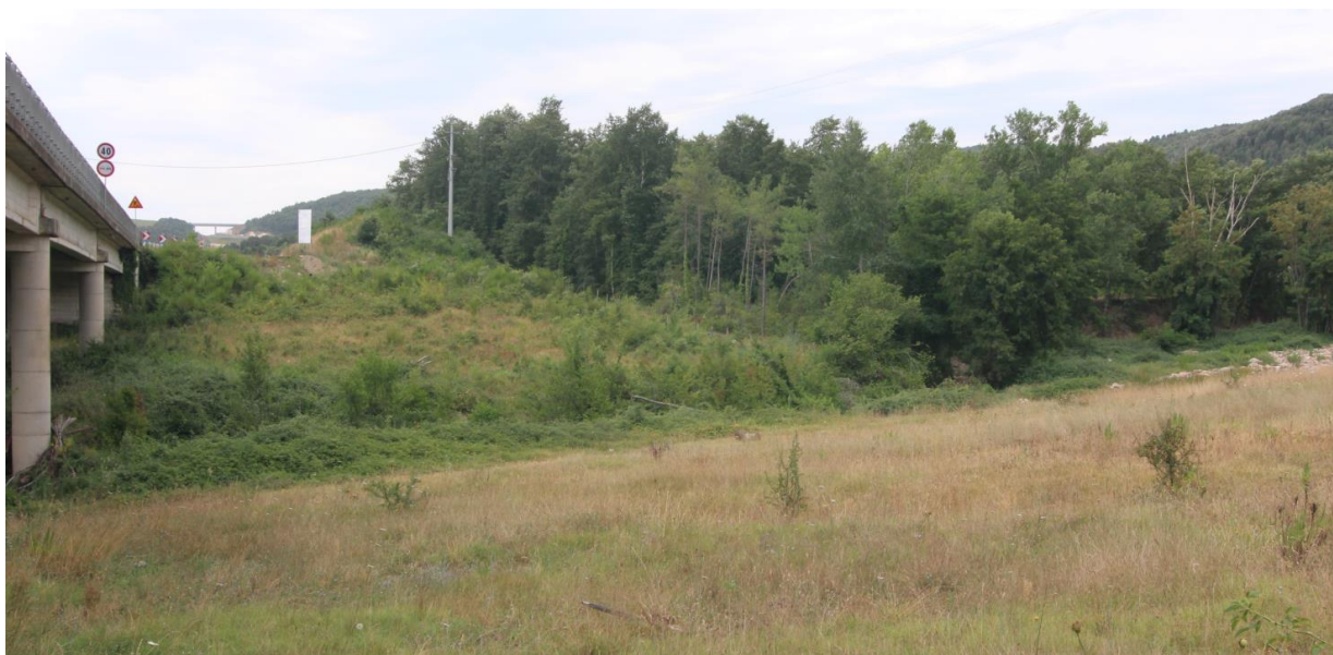
Figura 10.4 Vegetazione descritta a ovest del viadotto
