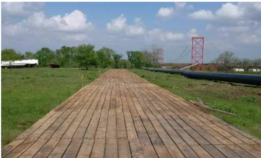
**Fig. 5.9 - Esempio di dispersori di carico installati su prati naturali**
