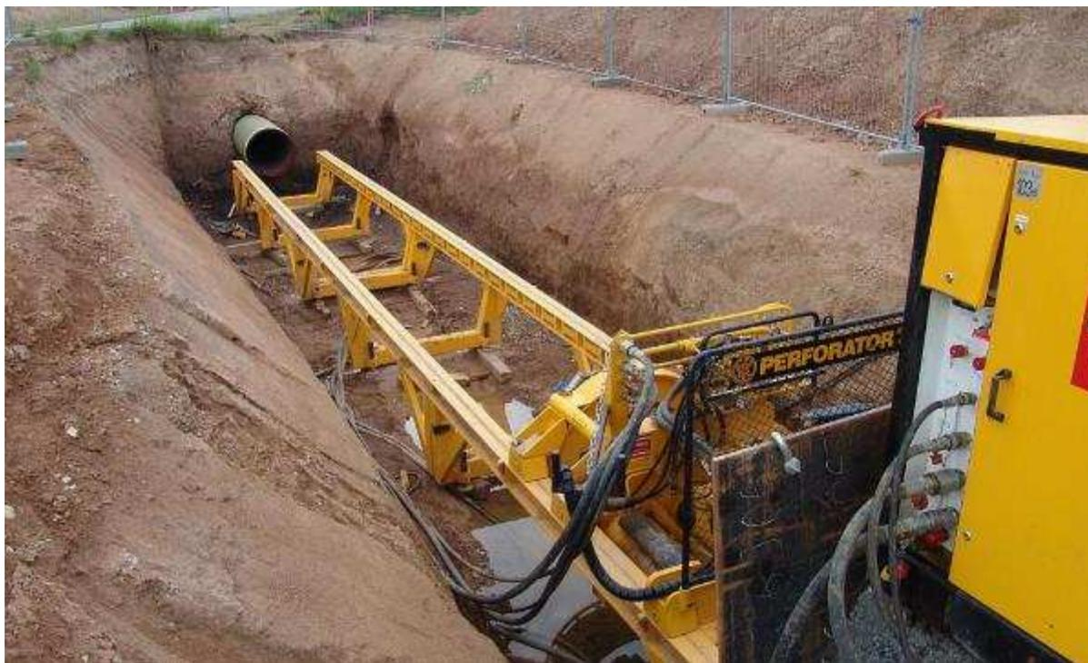
**Fig. 5.2 - Esempio di postazione di spinta ed inserimento del “tubo camicia”**
