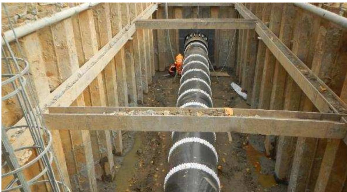
**Fig. 5.3 - Esempio di inserimento della condotta protetta con collari distanziatori all’interno del “tubo camicia”**
