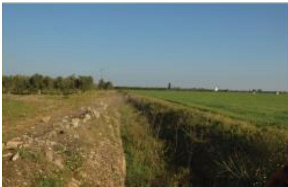
Canale di drenaggio delle acque superficiali
