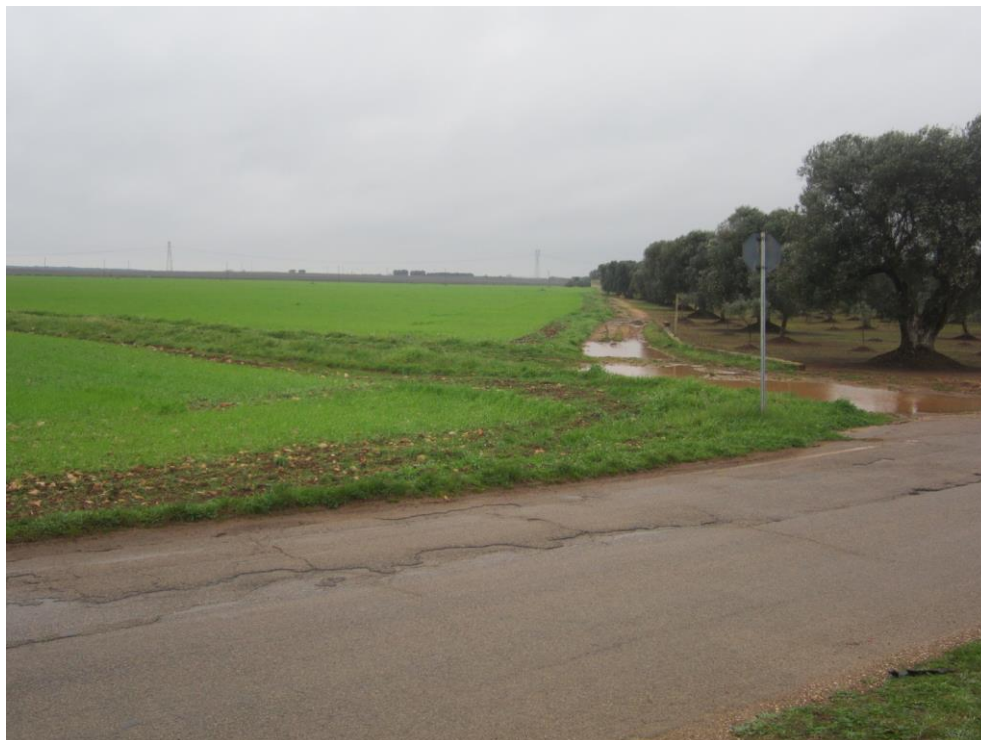
Zona di una Conca perimetrata dalla Carta Idrogeomorfologica AdB La ripresa è del 1 marzo 2018 dopo numerosi giorni di pioggia
