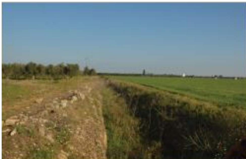
Canale di drenaggio delle acque superficiali
