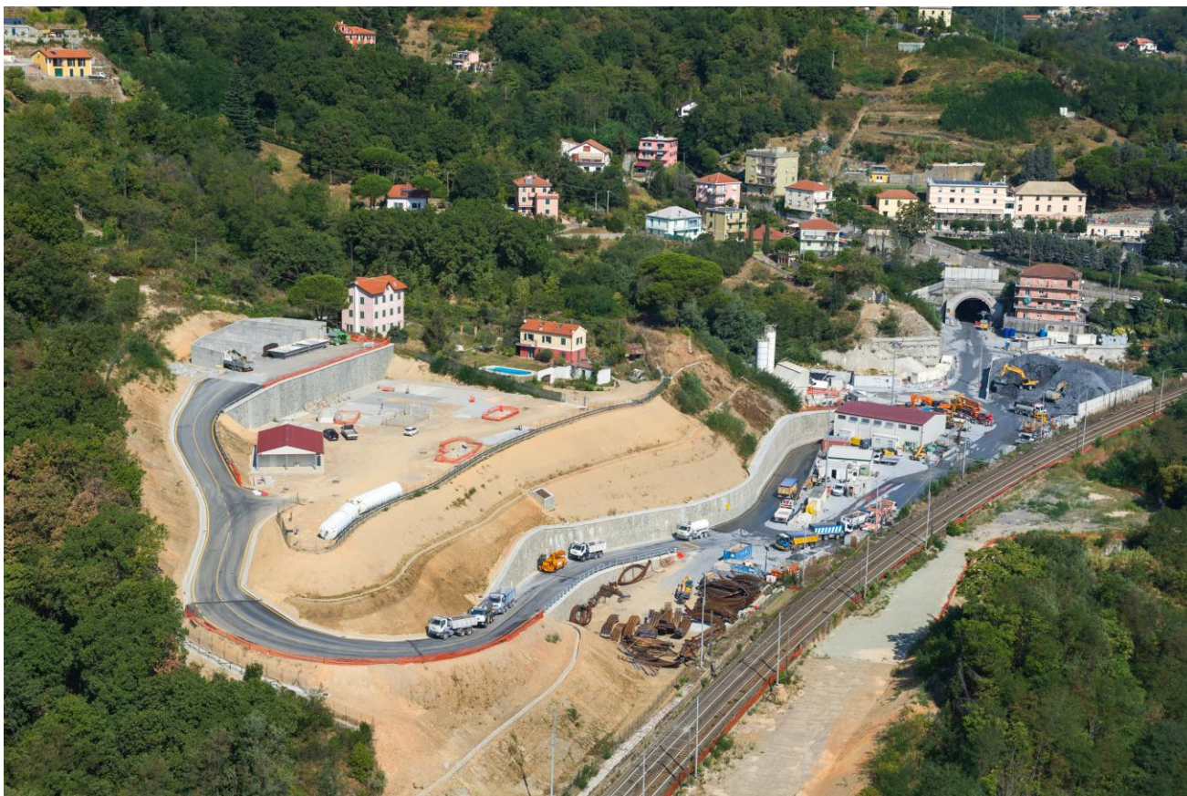
Figura 26 – Foto aerea dell’area di intervento su cui insiste il cantiere COL2
