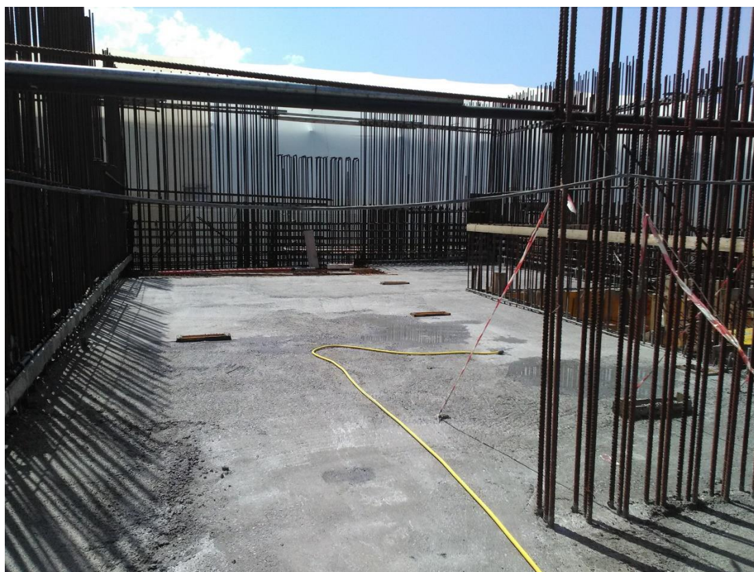
Figura 3.1/3 – Vista del solaio realizzato
