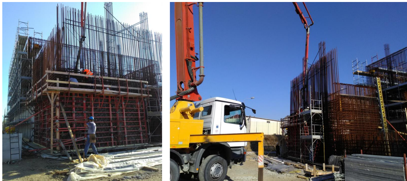
Figura 3.1/2 – getto delle strutture in elevazione (14.06.2017)
