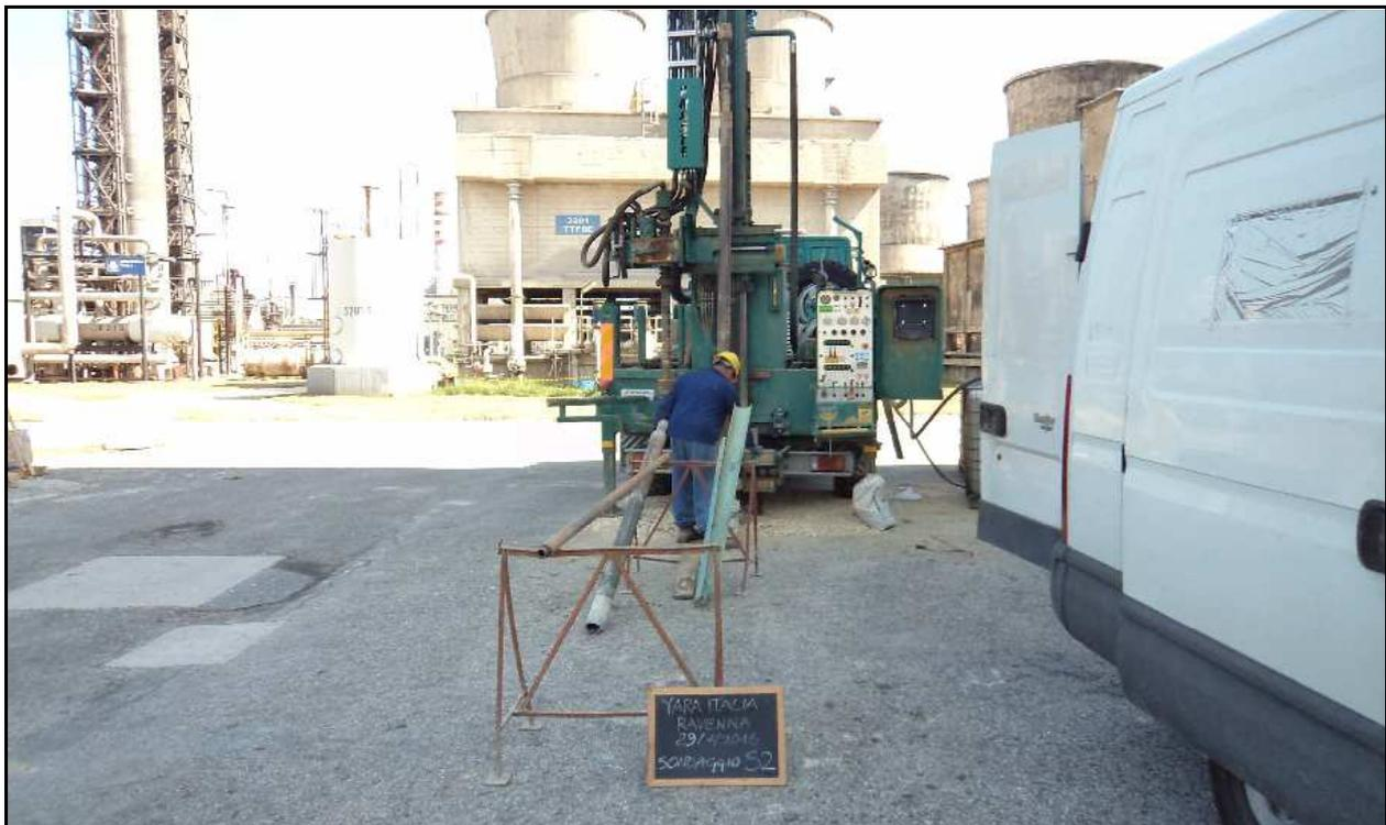
Foto 14: Sondaggio S2 – Posizionamento sonda in corrispondenza della trincea T2
