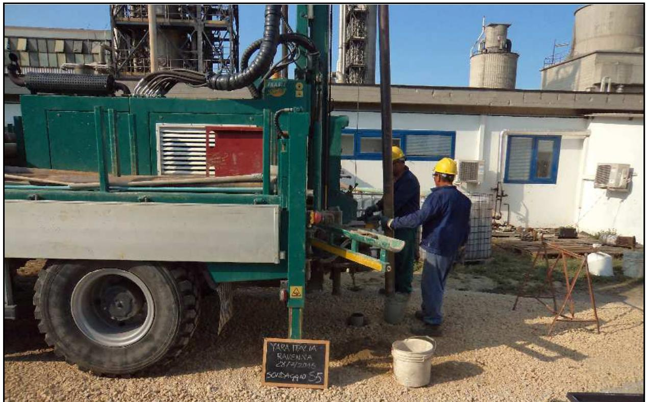
Foto 22: Sondaggio S5 – Posizionamento in corrispondenza della trincea T5
