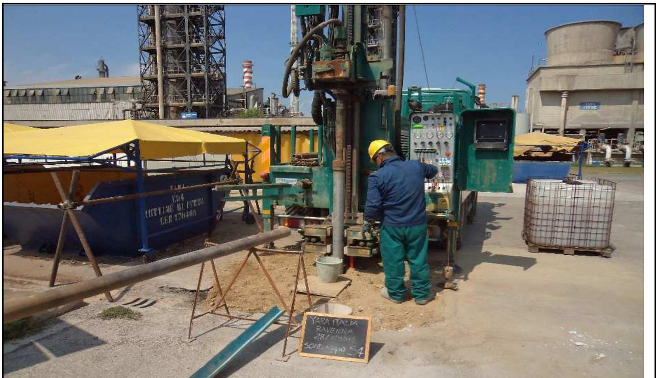
Foto 18: Sondaggio S4 – Posizionamento in corrispondenza della trincea T4
